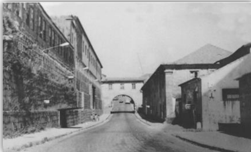
Fig. 10 - Antigo Quartel Caçadores - Actual UBI
