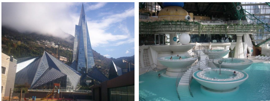
10. Uso de novos materiais no edifício Caldea, Andorra
