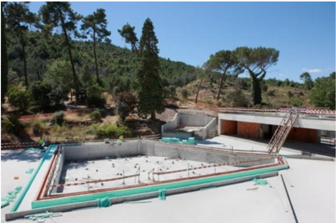
29. Imagem da construção da piscina exterior e bar.
