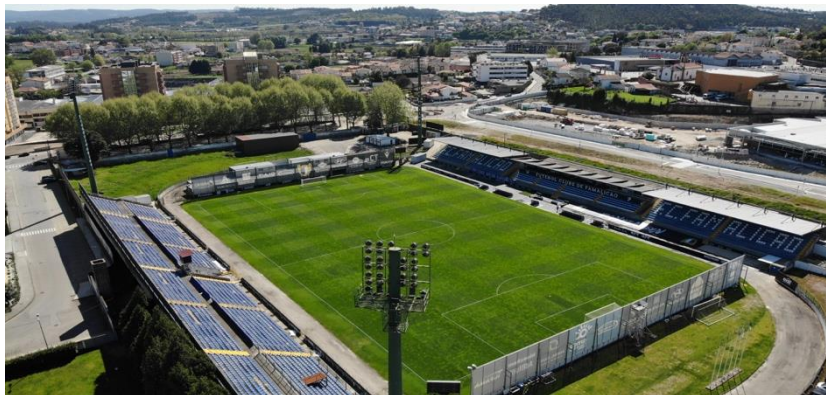
Figura 4. Bancada Nascente à esquerda e bancada poente à direita, do Estádio Municipal de Famalicão
