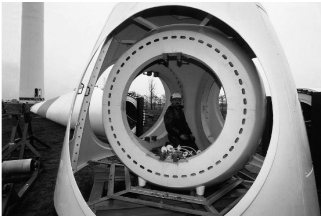
Figura 3.12 – Cubo do rotor esférico da turbina de 1,5 MW da NEG Micon com regulação Stall durante a instalação [Burton01].
