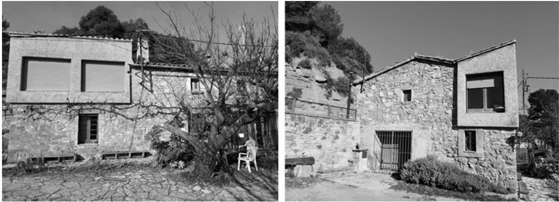
Figura 9 - Projeto "108ERA Reforma de masia a Granera", Estado original, 2020
