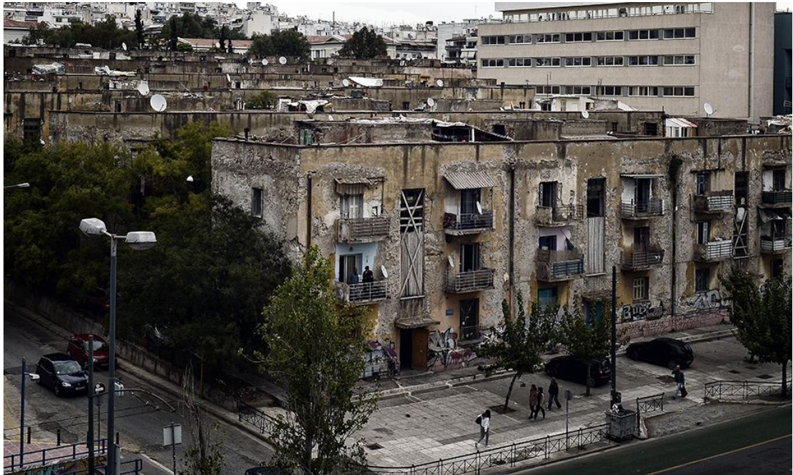
Figura 9 - Edificações degradadas e abandonadas em Atenas, Grécia
