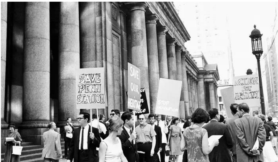
Figura 7 - Estação Pensilvânia, exterior e interior e Manifestações antes da demolição
