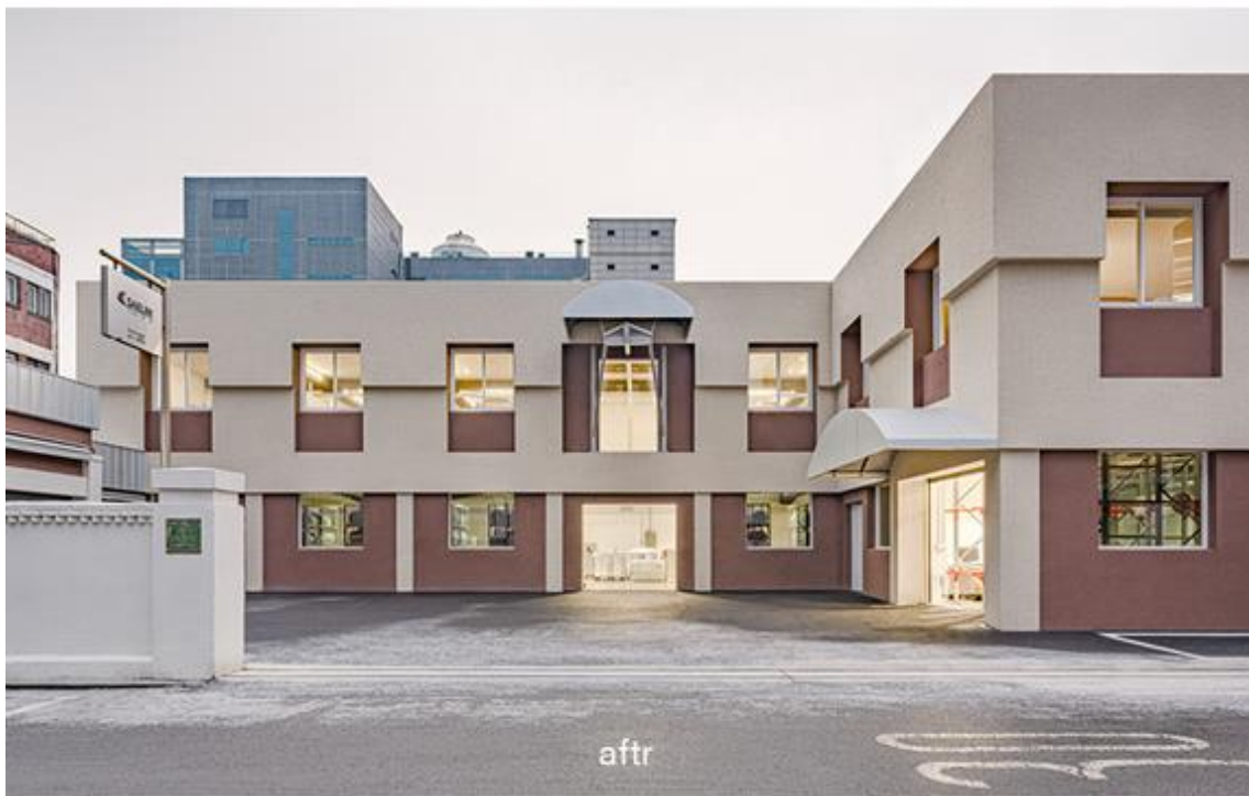
Figura 6 - Projeto de reabilitação "Pad(dock)", 2024. Este projeto conta com a transformação de um edifício fabril num complexo de escritórios
