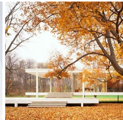
057- Farnsworth House, Mies van der Rohe
