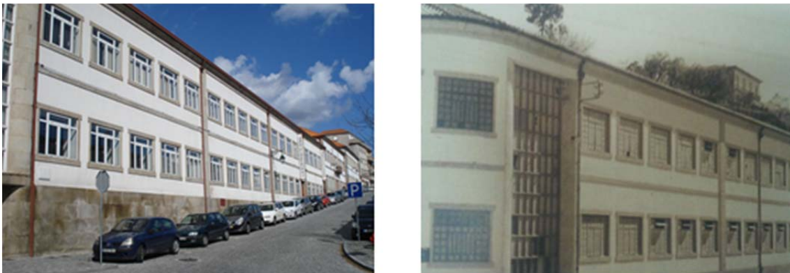
Figura 8 - Edifício Paulo Oliveira antes e depois da recuperação
