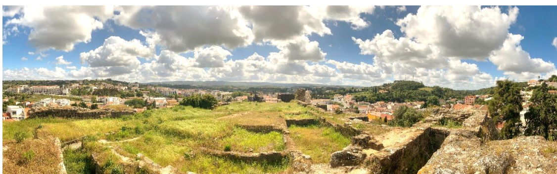
FIGURA 73: REGISTO FOTOGRÁFICO DAS CARATERÍSTICAS DAS RUÍNAS DO CASTELO DE ALCOBAÇA.
