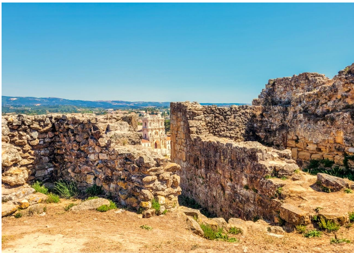
FIGURA 57: RUÍNAS DO CASTELO DE ALCOBAÇA.
