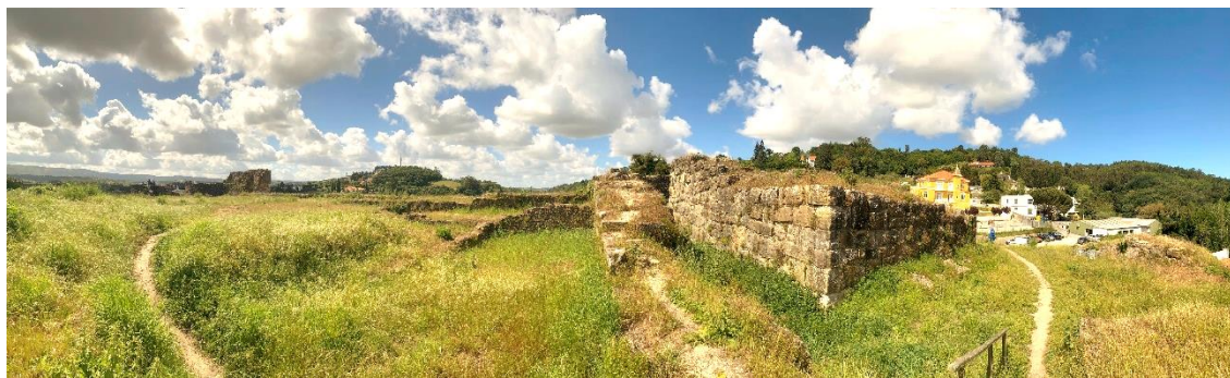
FIGURA 72: REGISTO FOTOGRÁFICO DAS CARATERÍSTICAS DAS RUÍNAS DO CASTELO DE ALCOBAÇA.
