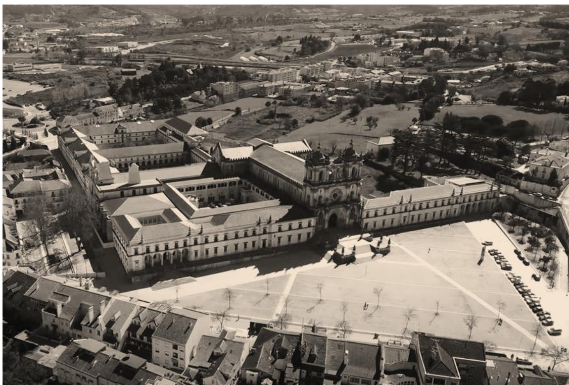
FIGURA 35: VISTA AÉREA DO ROSSIO DEPOIS DA INTERVENÇÃO. (RIBAS, 2017)
