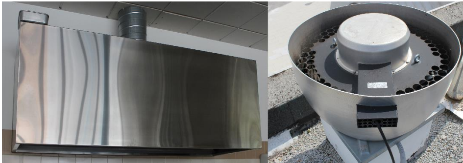
Figura 4.8 Sistema de extração de fumos - edifício A.
