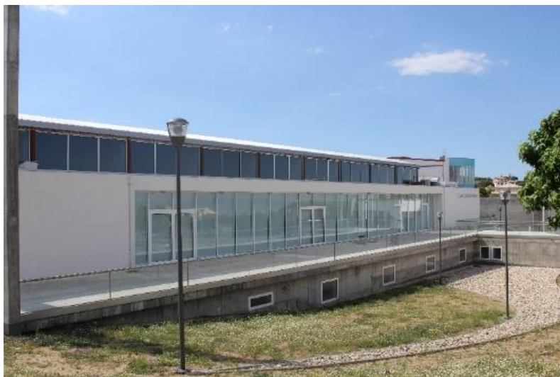
Figura 4.13 Polidesportivo da Mêda - edifício B.
