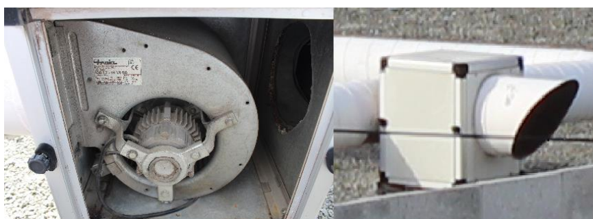
Figura 4.7 Caixa de ventilação - edifício A.
