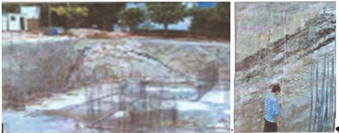
Figura 3.21 - Fotografias obtidas em fase de obra para a implantação da Biblioteca Municipal da Covilhã, evidenciando as elevadas heterogeneidades do maciço de fundação (fotos facultadas por Ferreira Gomes)
