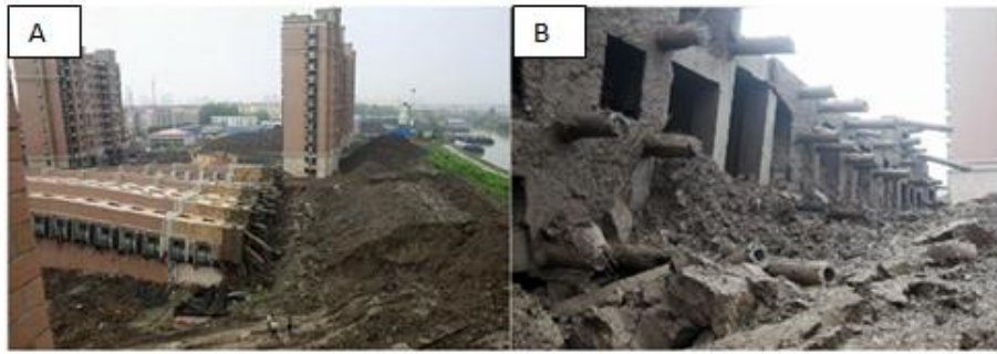
Figuras 2.52 - Desabamento de um prédio em Xangai (Foncillas, 2009)
