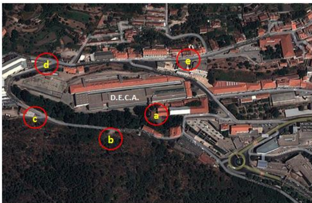
Figura 3.36 - Locais de estudo individualizado no Caso Nº6 : Edifício paralelo ao DECA (a), Travessa da Fonte Santa (b a d), Rua Marquês de Pombal (e)
