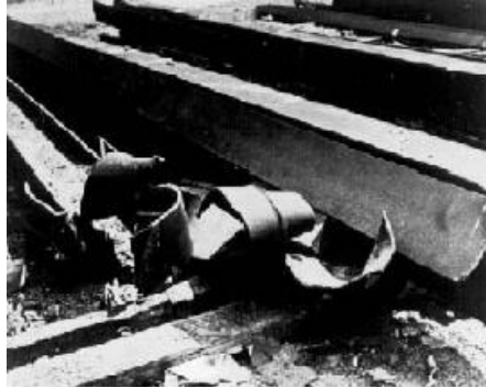
Figura 2.46 - Estacas metálicas com elevados danos estruturais (Schnaid et al. , 2005, in Carvalho, 2010)
