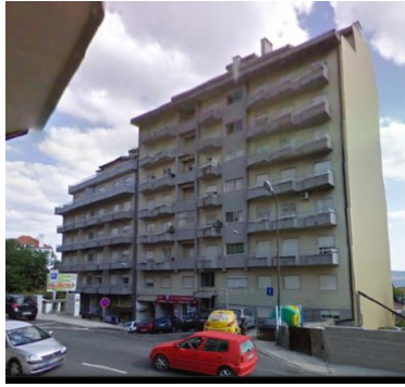
Figura 3.26 - Edifício com potenciais problemas de origem geotécnica na Rua José Ramalho
