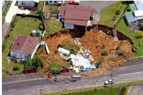
Figura 2.15 - Pode-se observar os efeitos da subsidência do solo devido aos trabalhos realizados numa mina (Eco denúncia, 2006, in Carvalho, 2010)
