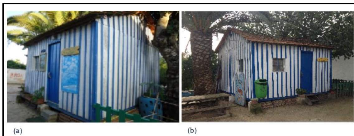
Figura 62 - Edifício com melhor classificação MA, (a) edifício “PAL_4” em 2014 (Almeida, F., 2014: DECMaVi); (b) edifício “PAL_4_16” na análise atual.
