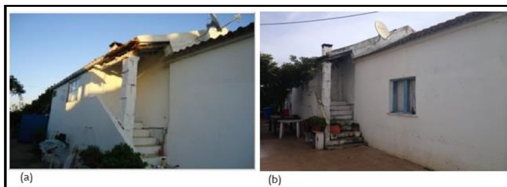
Figura 68 - Edifício com pior classificação MA, (a) edifício “PAL_5” em 2014 (Almeida, F., 2014: DECMaVi); (b) edifício “PAL_5_16” na análise atual.
