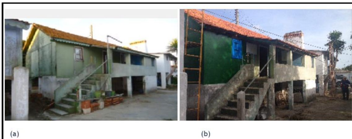
Figura 49 - Edifício com melhorias, mas com mesmo nível do EC, (a) edifício “PAL_7” em 2014 (com Almeida, F., 2014: DECMaVi); (b) edifício “PAL_7_16” na análise atual.
