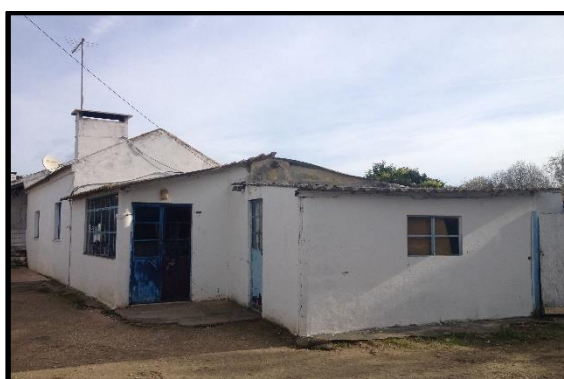
Figura 69- Edifício com pior classificação MA, (a) edifício “PAL_5” em 2014 na análise atual.
