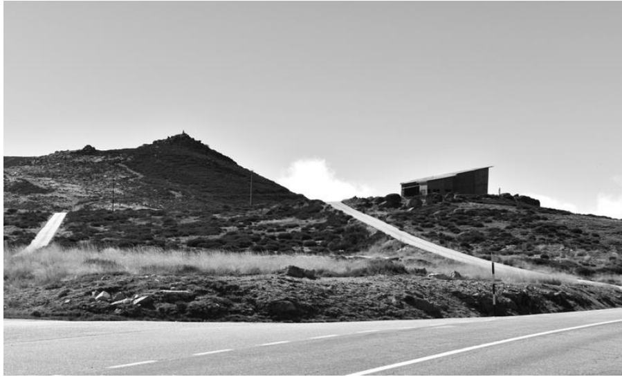
Figura. 16. Vista do local de Intervenção da estrada Nacional N338.
