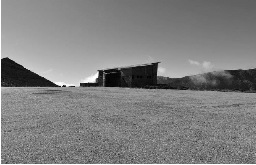
Figura. 13. Vista do estacionamento do terminal do teleférico.
