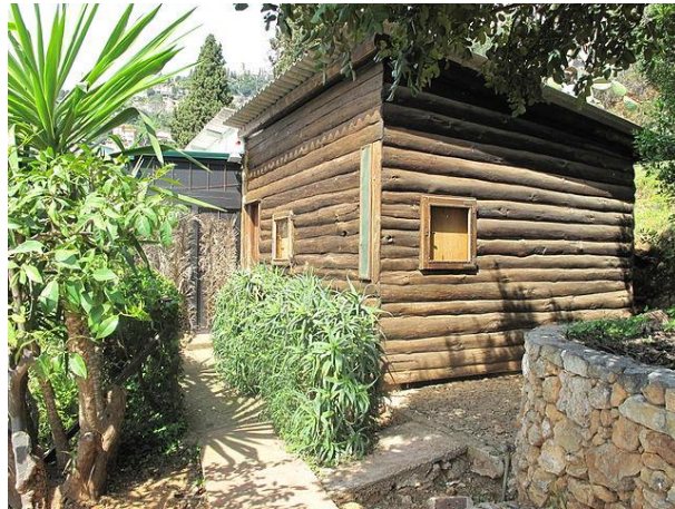
Figura 92 - Vista exterior de Le Cabanon.
