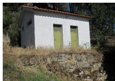
Figura 116 - Fotografia das instalações sanitárias existentes.
