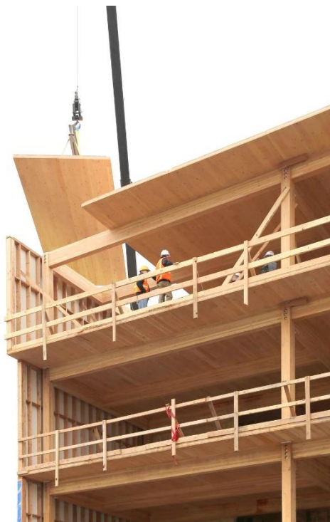
53. processo de montagem de um edifício com estrutura em madeira CLT. (Lever Architecture, 2024)
