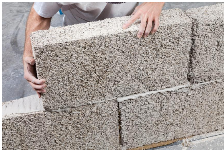
51. Textura de um bloco de Hempcrete. O material tem diversas possibilidades de aplicação, seja em blocos, em painéis ou em spray durante a cofragem das paredes. (IsoHemp, 2020)
