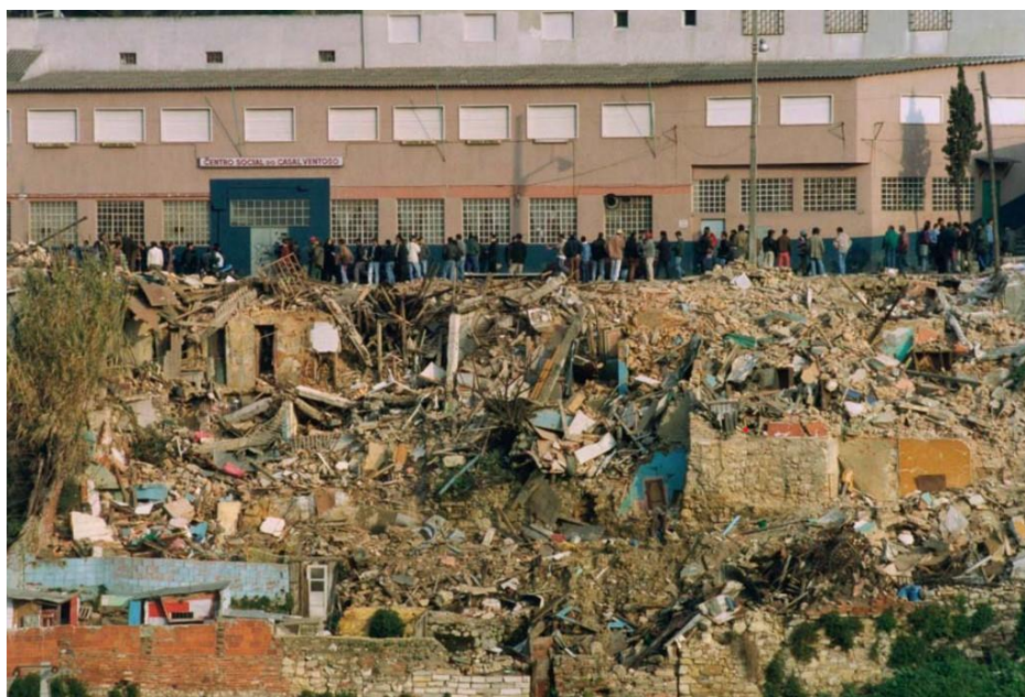
34. Casal ventoso durante a sua demolição. O bairro foi um dos maiores exemplos da atividade do PER (Gil, 1999)
