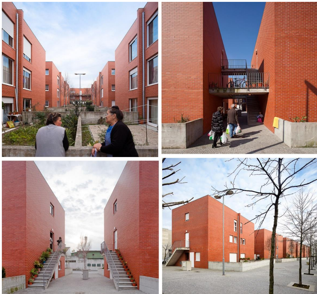
62. Conjunto em Monte Espinho, Leça da Palmeira. A arquiteta Paula Petiz executa de forma louvável em seu projeto a preservação da escala humana, dos percursos pedonais, da permeabilidade física e visual e da formação comunitária. (A Caixa Negra, 2020)
