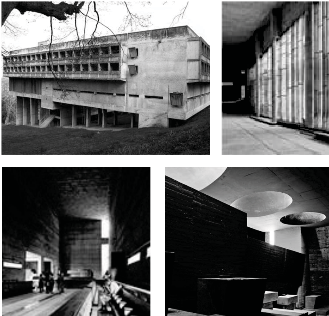
Figura 50- Convento de Santa Maria de La Tourette, França. Vista exterior e sobre o interior
