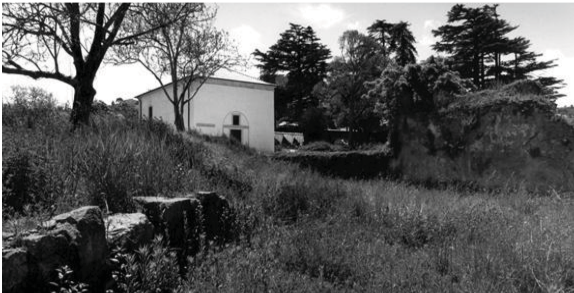
Figura 14- Celeiro Agrícola do Mosteiro de Santa Maria de Alcobaça. Estrutura utilitária hoje reabilitada.
