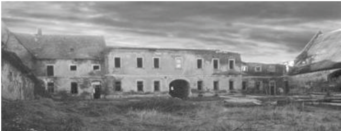
Figura 55- Ruína Barroca pré-existentes e restauradas na edificação do Mosteiro de Novy Dvur.
