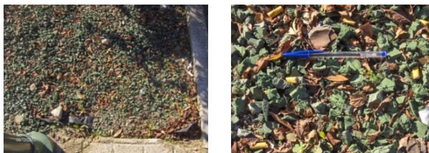
Figura 3.14 - Impermeabilização no separador central
