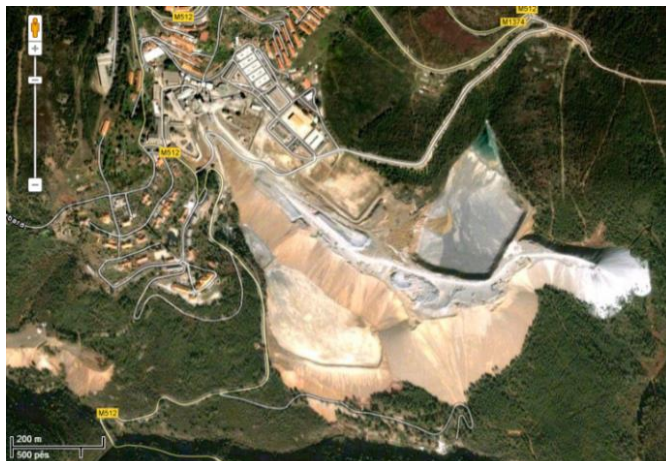
Figura 5.7 - Vista aérea das escombrelras da concessão da Barroca Grande (fonte: Googlemaps_2013)
