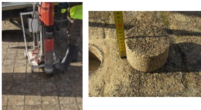
Figura 5.28 - Carotagem in situ no passeio
