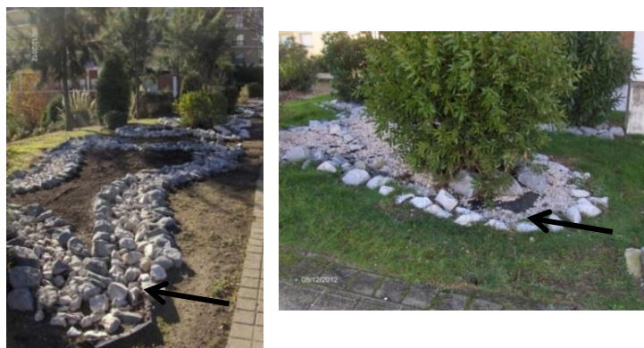
Figura 3.15 - Tela de impermeabilização nos espaços verdes
