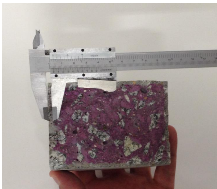
Figura 5.3 - Medição da profundidade de carbonatação.
