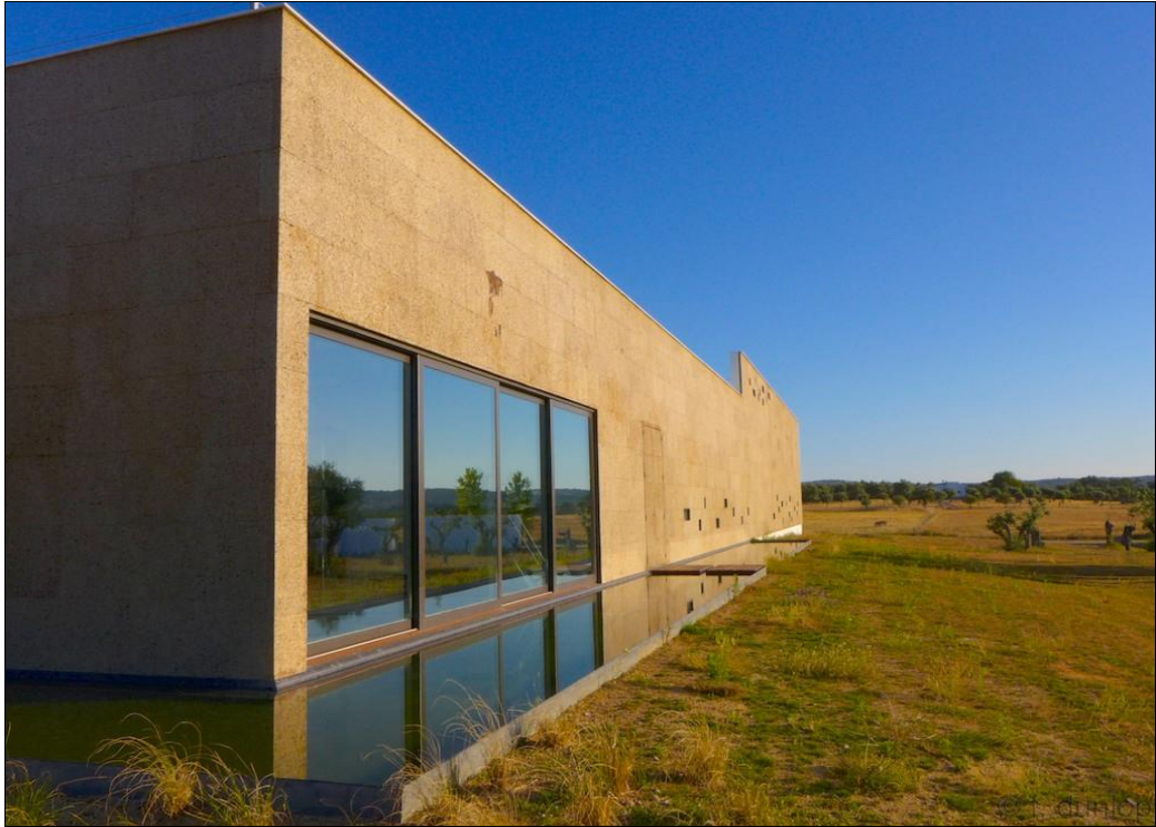
Figura 17 - Revestimento em cortiça do EcorkHotel
