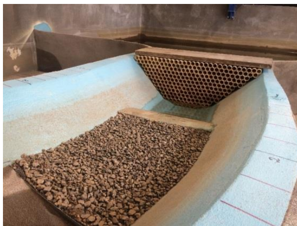
Figura 3.6- Estabilização do caudal na entrada do canal[19]
