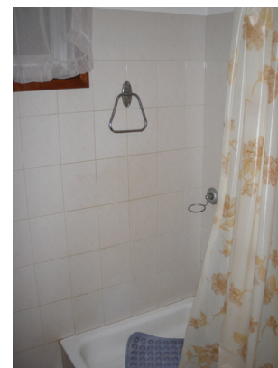
Figura 8.28 Toalheiro usado como barra de apoio no chuveiro.
