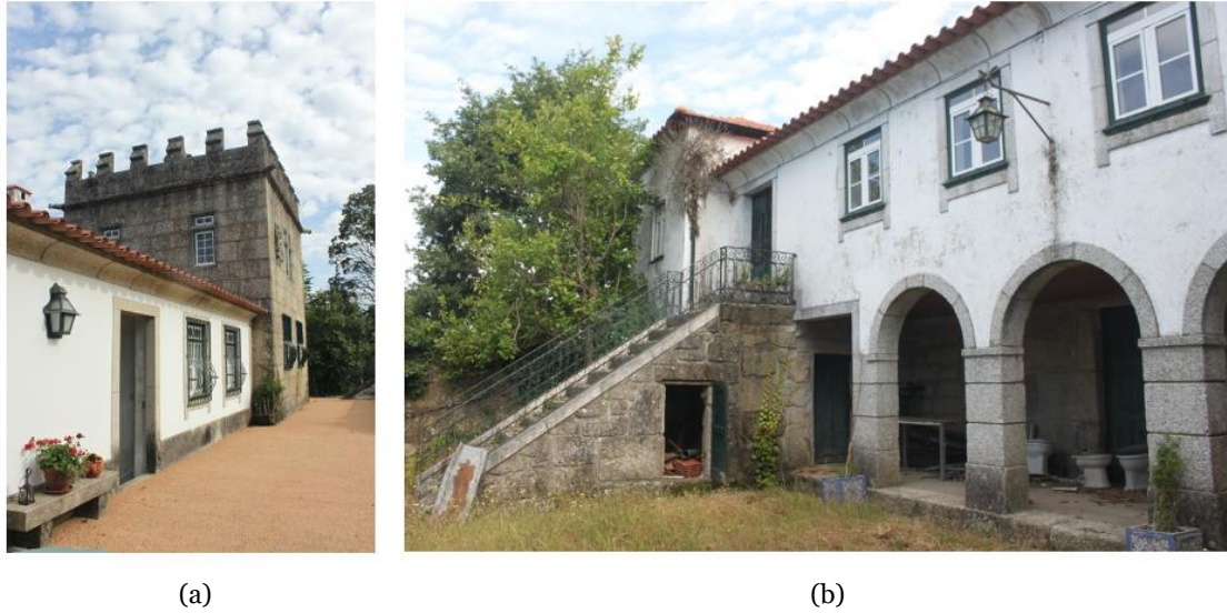
Figura 17 - Casa Quinta da Lage: (a) Alçado Principal do Edifício A; (b) Alçado Posterior do Edifício A.
