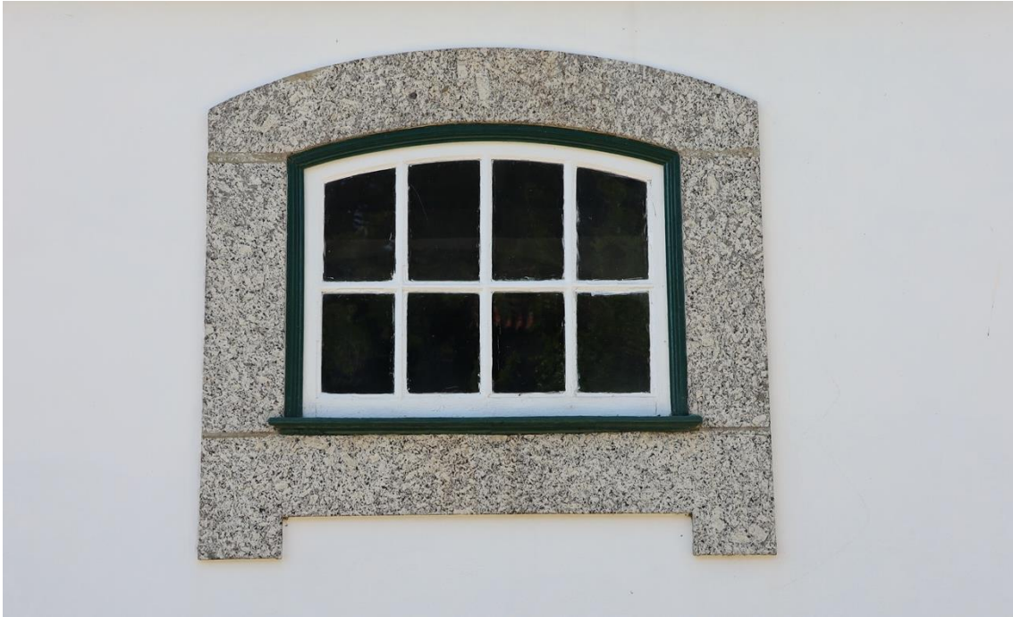
Figura 9 - Casa de Vila Verde: Exemplo de Janela de Verga com Lintel Curvilíneo;
