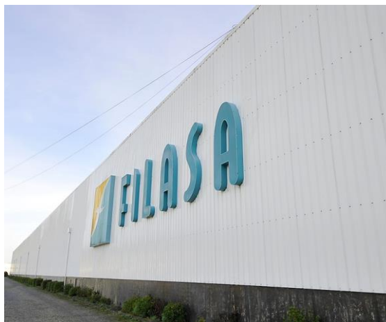
Figura 11 Instalações da empresa Filasa visitada pela autora Fonte: https://www.filasa.pt/sobre#qualidade
