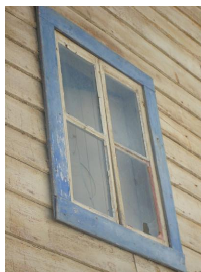
Fig. 83: Detalhe da janela de batente. Note-se a moldura de madeira em torno da mesma.
