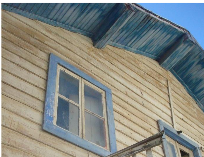
Fig. 82: Janela de batente aplicada na fachada principal do Palheiro.
