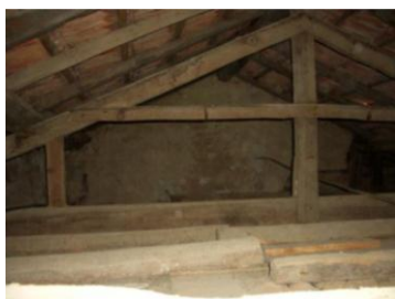
Fig. 57: Pormenor de asna tipo 2, Costa Nova. [5]
