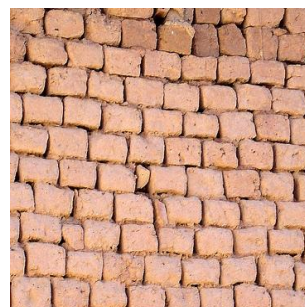
Fig. 40: Blocos de adobe, usados para fundações e chaminés. [40]
