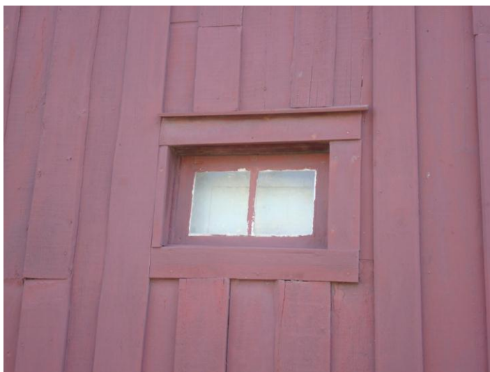
Fig. 85: Detalhe de janela de batente.
