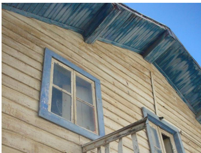
Fig. 97: Janela de batente. Note-se a portada interior.
