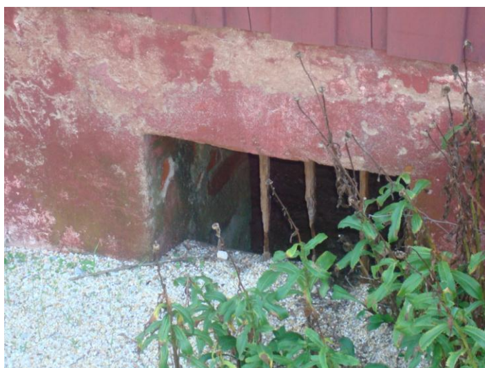
Fig. 42: Palheiro de José Estêvão. Detalhe dos blocos de adobe.
