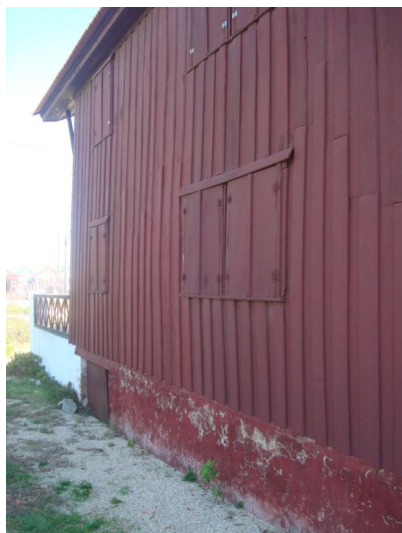
Fig. 67: Lateral do Palheiro de José Estêvão. Note-se o ripado vertical e a utilização de ripas normais em detrimento das ripas mata-juntas.
