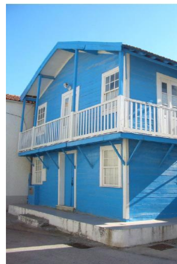
Fig. 46: Palheiro construído segundo o tipo construtivo de fundação sobre embasamento.
