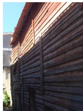
Fig. 65: Lateral de um Palheiro. Note-se o menor tratamento do aspecto final.
