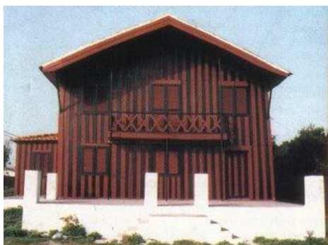
Fig. 16: Palheiro com tom avermelhado. Este Palheiro possui dois pisos, pois é uma construção habitacional de raiz. [20]
