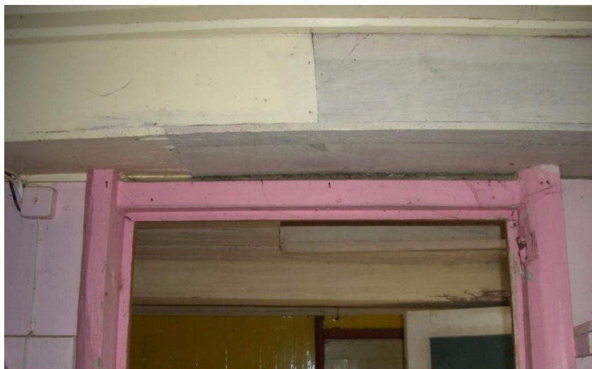
Fig. 51: Interior de um Palheiro. Os prumos, para além de suportarem a viga principal, formam entre si uma passagem (porta). [5]
