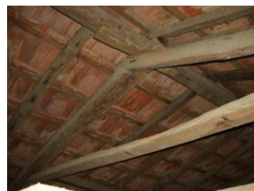
Fig. 58: Pormenor de asna tipo 3, Costa Nova. [5]
