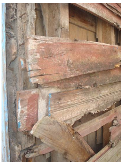
Fig. 60: Detalhe da estrutura com escoras.
