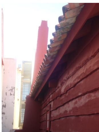
Fig. 70: Palheiro de ripado horizontal, no qual está apoiada a chaminé.
