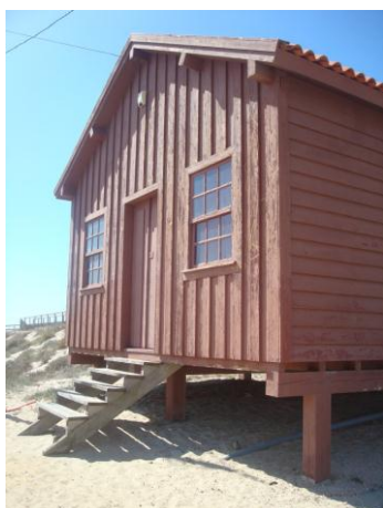
Fig. 63: Palheiro com ripado horizontal nas laterais e vertical nos topos.
