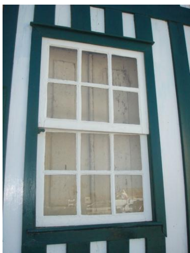
Fig. 96: Janela de guilhotina. Note-se as portadas interiores.
