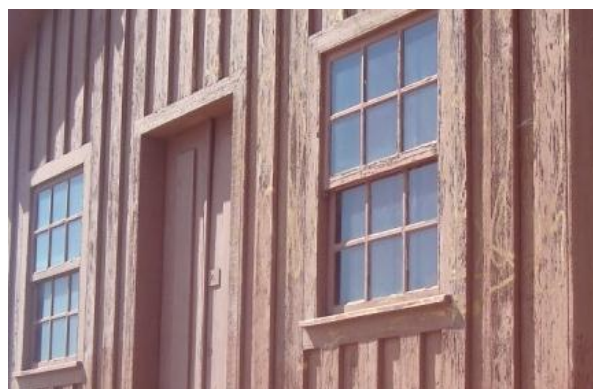
Fig. 80: Palheiro reconstruído, onde foram aplicadas janelas de guilhotina.
