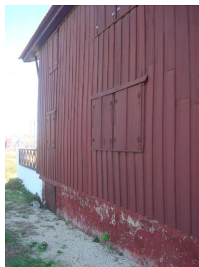
Fig. 43: Palheiro de José Estêvão. Palheiro construído sobre soco.
