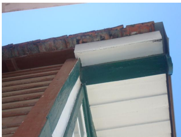
Fig. 99: Beiral lateral e frontal. Note-se o pouco espaço entre a ponta da telha e a parede vertical.
