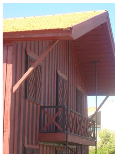
Fig. 105: Fachada do Palheiro de José Estêvão. Note-se o revestimento no beiral.
