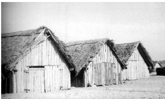
Fig. 5: Armazéns de sargaço, Póvoa do Varzim. [5]
