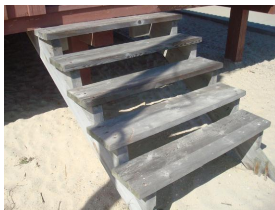
Fig. 78: Escada executada integralmente em madeira, vista geral.
