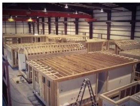
Figura 132 – Construção modular de madeira numa fábrica (Casa prefab, 2008)
