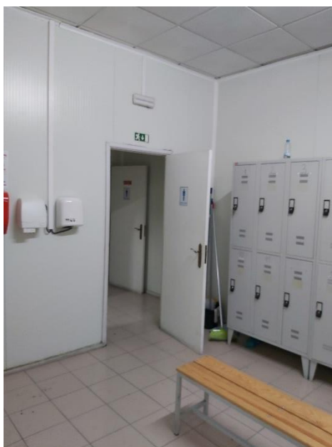
Figura 50 – Representação da sujidade nas instalações sanitárias da unidade 1.
