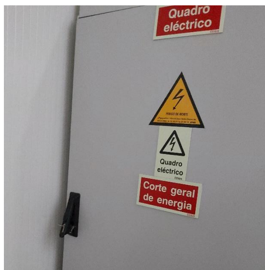
Figura 66 – Exemplo de um quadro elétrico aberto.
