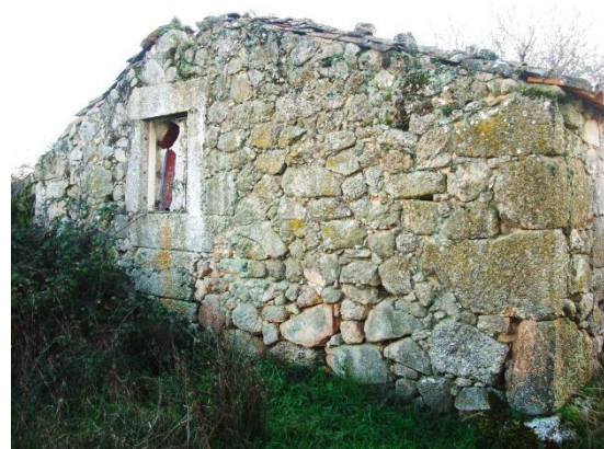
Foto. J - Fachada Norte das Ruínas.
