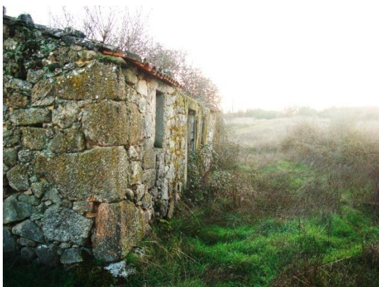
Foto. J(a) - Fachada das Ruínas.
