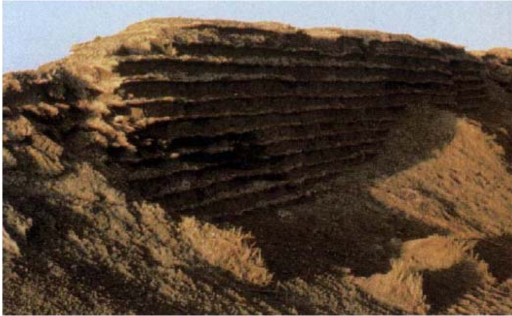
Figura 1.1 - Muro de terra reforçado com canas, primeiro século d.C. (Thinagaram e Ramasamy, 2004).
