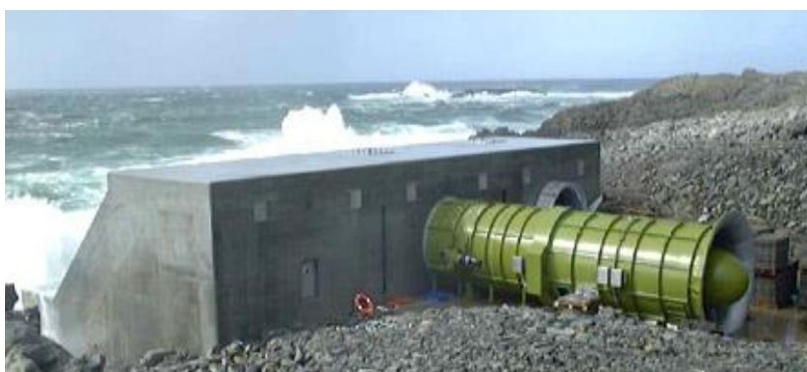
Figura 4.3: Central LIMPET, adaptado de [58].
