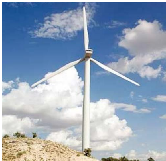
Figura 3.11: Turbina de eixo horizontal, adaptado de [47].
