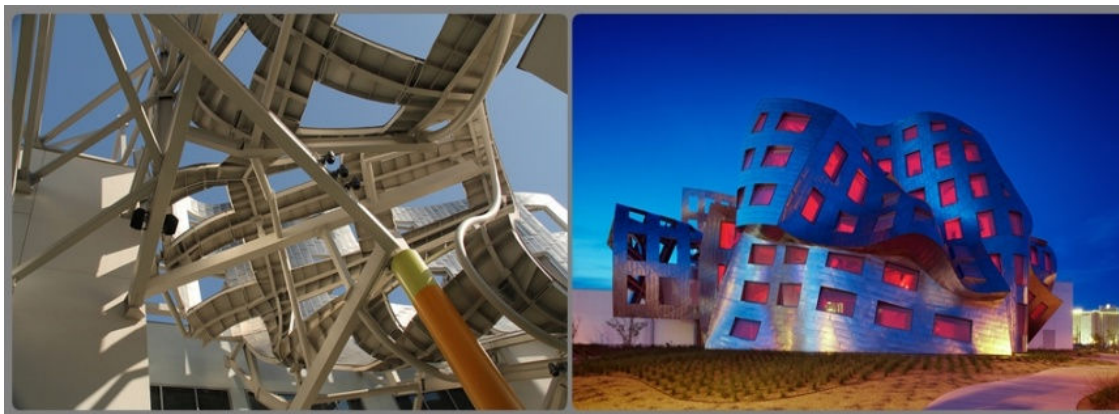
Figura 11 - Obra com fachada metálica, Clínica Lou Ruvo Center, Frank Gehry [39]
