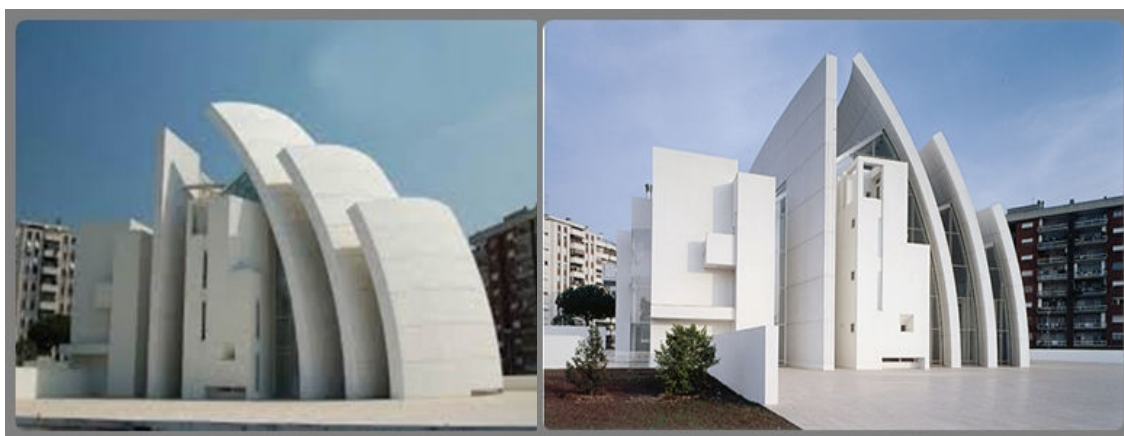
Figura 13-Obra arquitetónica em betão, Igreja Jubileu, Richard Meier [42]
