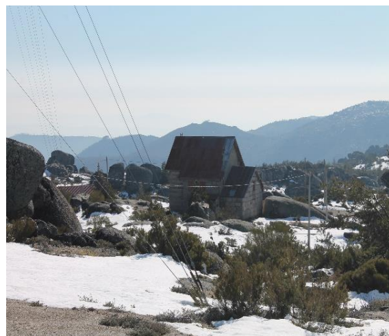
Figura 122 - Chalé em granito, privado
