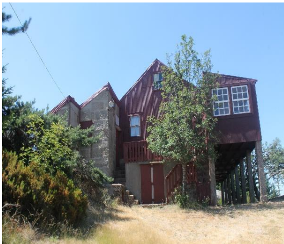
Figura 115 - Chalé Moinho de Vento, privado
