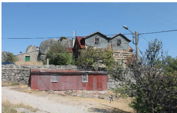
Figura 100 - Fachada Sul Casa do Guarda
