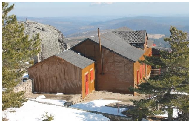
Figura 81 - Chalé completamente revestido a zinco
