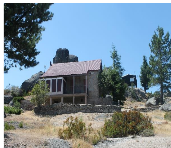
Figura 114 - Casa em granito, privado
