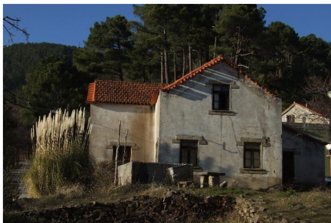
Figura 130 - Casa do Guarda Manteigas
