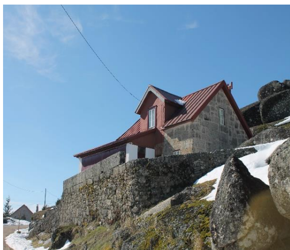
Figura 123 - Chalé em granito, privado
