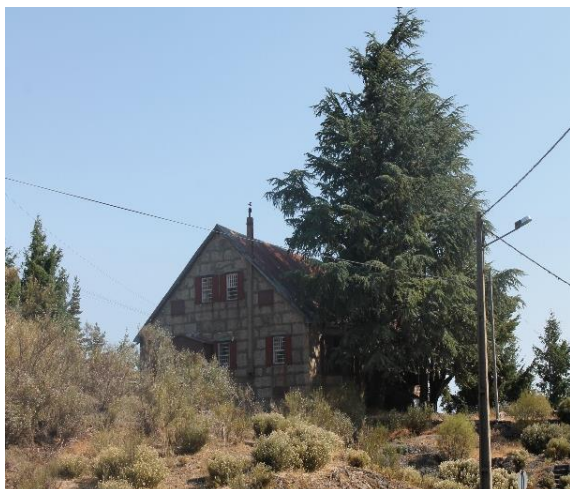
Figura 109 - Chalé em granito
