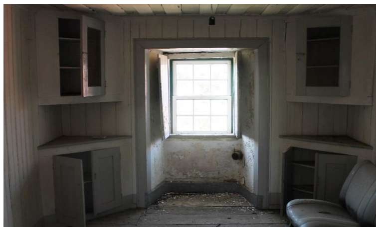
Figura 141 - Mobiliário incorporado nas paredes
