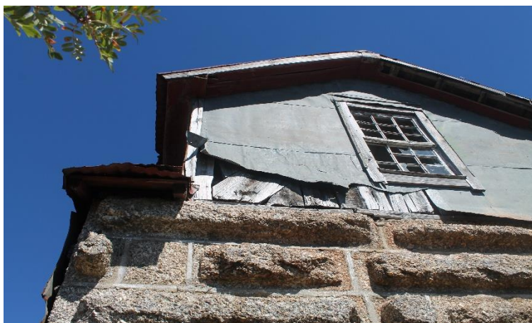
Figura 140 - Estrutura em madeira e aço no piso superior
