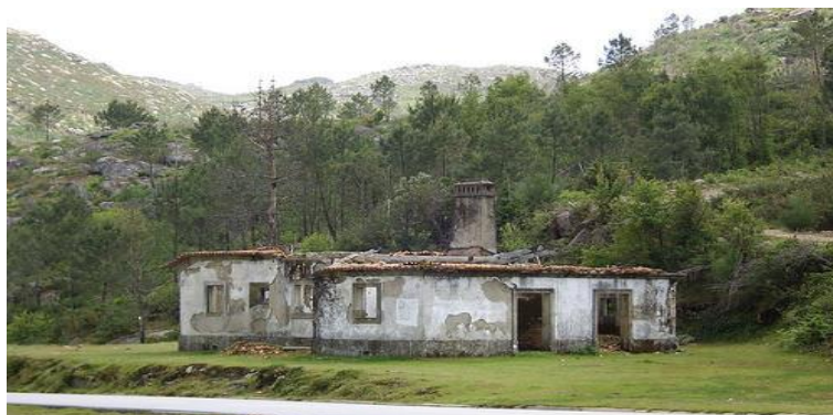
Figura 131 - Casa do guarda florestal S. João d'Arca, Serra de D'Arca
