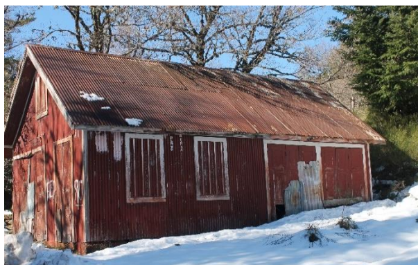
Figura 80 -Telhado antigo em zinco
