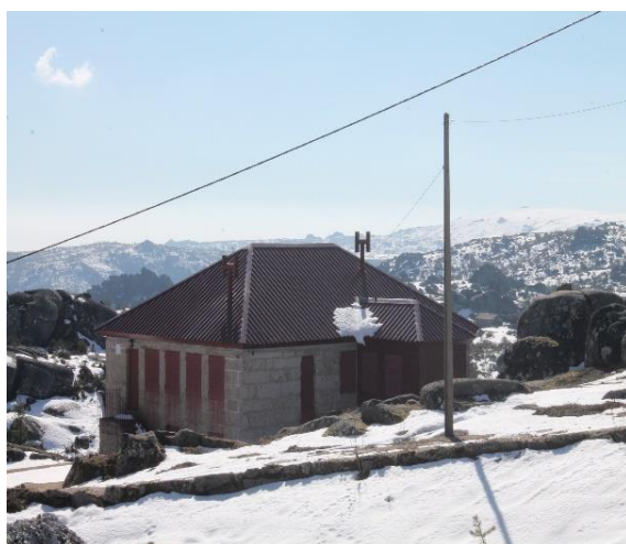
Figura 125 - Chalé em granito, privado
