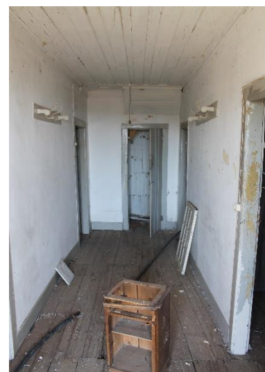
Figura 144 - Corredor piso inferior
