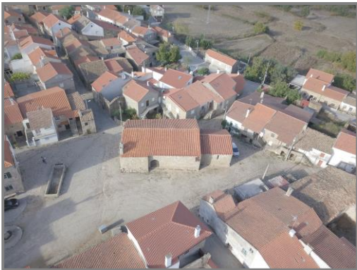
Figura 2.53 - Alfaiates, Igreja da Santa Casa da Misericórdia. Informações GPS drone: Latitude: 40;23;30.39590... Longitude: 6;54;48.74160... Altitude: 855.342 Foto tirada em 20 de outubro de 2018. Fonte: drone Mavic Pro
