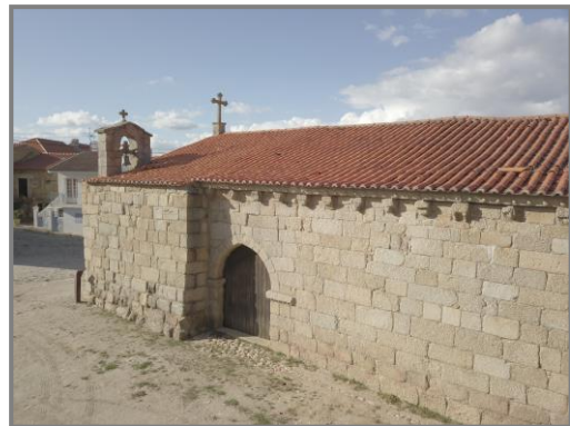
Figura 2.42 - Alfaiates, Igreja da Santa Casa da Misericórdia. Informações GPS drone: Latitude: 40;23;31.41020... Longitude: 6;54;48.51090... Altitude: 815.042 Foto tirada em 20 de outubro de 2018. Fonte: drone Mavic Pro
