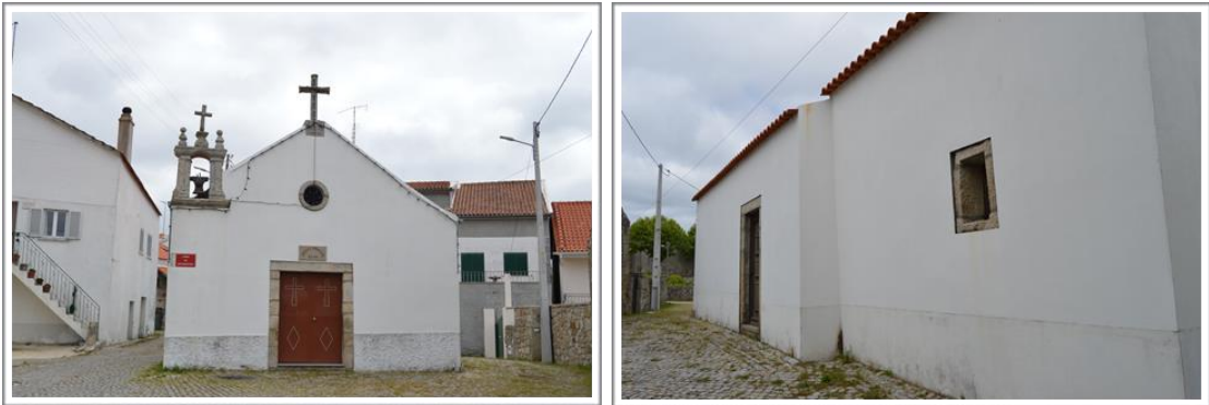
Figuras 2.14 e 2.15 - Vila do Touro, Capela de São Sebastião. Fotos tiradas em 12 de junho de 2018. Fonte: Telma Rebelo
