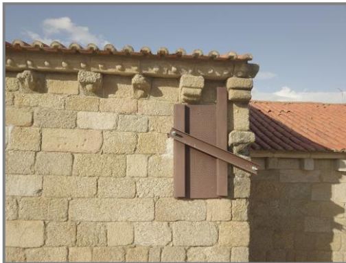
Figura 2.41 - Alfaiates, Igreja da Santa Casa da Misericórdia. Informações GPS drone: Latitude: 40;23;31.58840... Longitude: 6;54;48.46340... Altitude: 813.842 Foto tirada em 20 de outubro de 2018. Fonte: drone Mavic Pro
