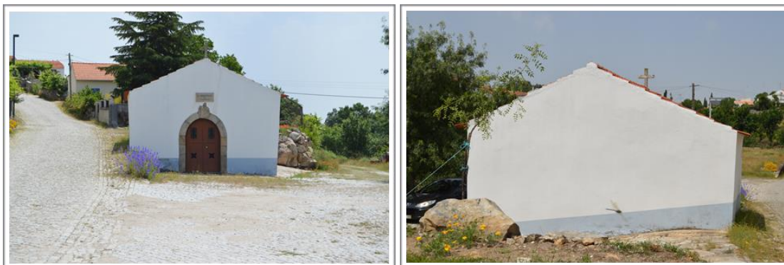
Figuras 2.26 e 2.27 - Vilar Maior, Capela de São Sebastião. Fotos tirada em 25 de junho de 2018. Fonte: Telma Rebelo
