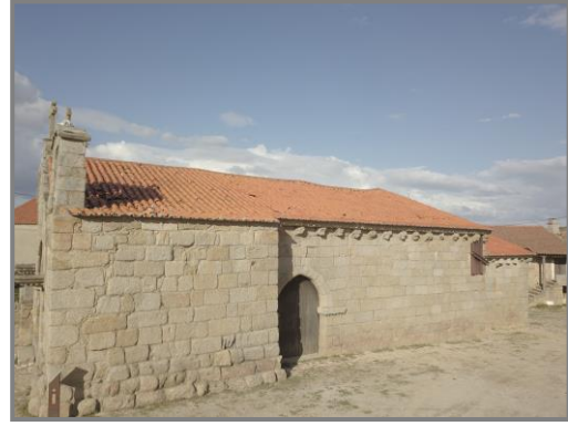
Figura 2.40 - Alfaiates, Igreja da Santa Casa da Misericórdia. Informações GPS drone: Latitude: 40;23;31.33369... Longitude: 6;54;49.11109... Altitude: 814.742 Foto tirada em 20 de outubro de 2018. Fonte: drone Mavic Pro
