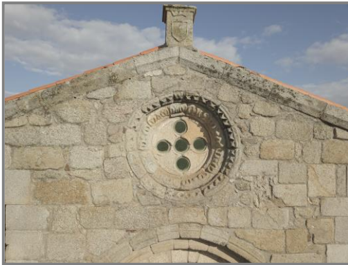
Figura 2.49 - Alfaiates, Igreja da Santa Casa da Misericórdia. Informações GPS drone: Latitude: 40;23;31.88829... Longitude: 6;54;49.30059... Altitude: 815.242 Foto tirada em 20 de outubro de 2018. Fonte: drone Mavic Pro
