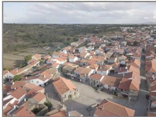
Figura 2.54 - Alfaiates, Igreja da Santa Casa da Misericórdia. Informações GPS drone: Latitude: 40;23;32.44149... Longitude: 6;54;51.63390... Altitude: 855.342 Foto tirada em 20 de outubro de 2018. Fonte: drone Mavic Pro
