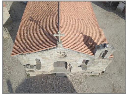
Figura 2.50 - Alfaiates, Igreja da Santa Casa da Misericórdia. Informações GPS drone: Latitude: 40;23;31.87469... Longitude: 6;54;49.38520... Altitude: 824.542 Foto tirada em 20 de outubro de 2018. Fonte: drone Mavic Pro
