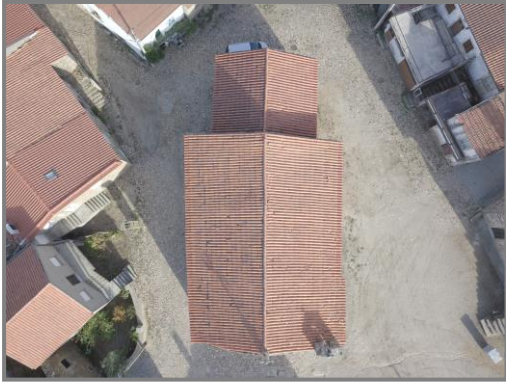
Figura 2.51 - Alfaiates, Igreja da Santa Casa da Misericórdia. Informações GPS drone: Latitude: 40;23;31.95639... Longitude: 6;54;48.68340... Altitude: 847.242 Foto tirada em 20 de outubro de 2018. Fonte: drone Mavic Pro
