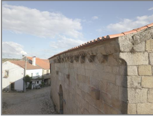
Figura 2.47 - Alfaiates, Igreja da Santa Casa da Misericórdia. Informações GPS drone: Latitude: 40;23;32.16990... Longitude: 6;54;49.06959... Altitude: 813.442 Foto tirada em 20 de outubro de 2018. Fonte: drone Mavic Pro
