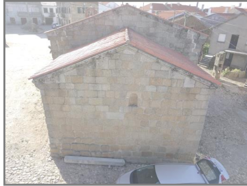
Figura 2.44 - Alfaiates, Igreja da Santa Casa da Misericórdia. Informações GPS drone: Latitude: 40;23;31.90410... Longitude: 6;54;49.81139... Altitude: 816.642 Foto tirada em 20 de outubro de 2018. Fonte: drone Mavic Pro
