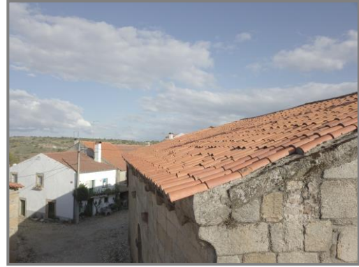
Figura 2.48 - Alfaiates, Igreja da Santa Casa da Misericórdia. Informações GPS drone: Latitude: 40;23;32.16990... Longitude: 6;54;49.06959... Altitude: 813.442 Foto tirada em 20 de outubro de 2018. Fonte: drone Mavic Pro
