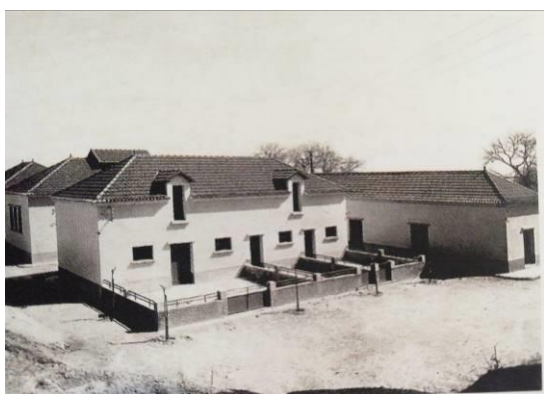
Figura 3-Matadouro em construção 1938 a 1940 (Ferreira, 2000)
