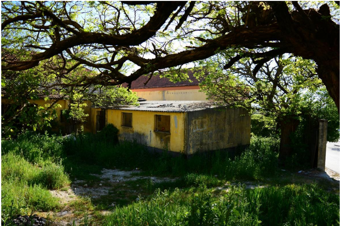
Figura 23-Estado atual entrada do estábulo (do autor)
