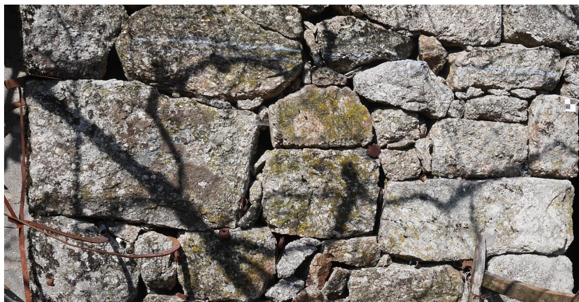
Figura 9 - Fachada de alvenaria de pedra de formas e tamanhos irregulares
