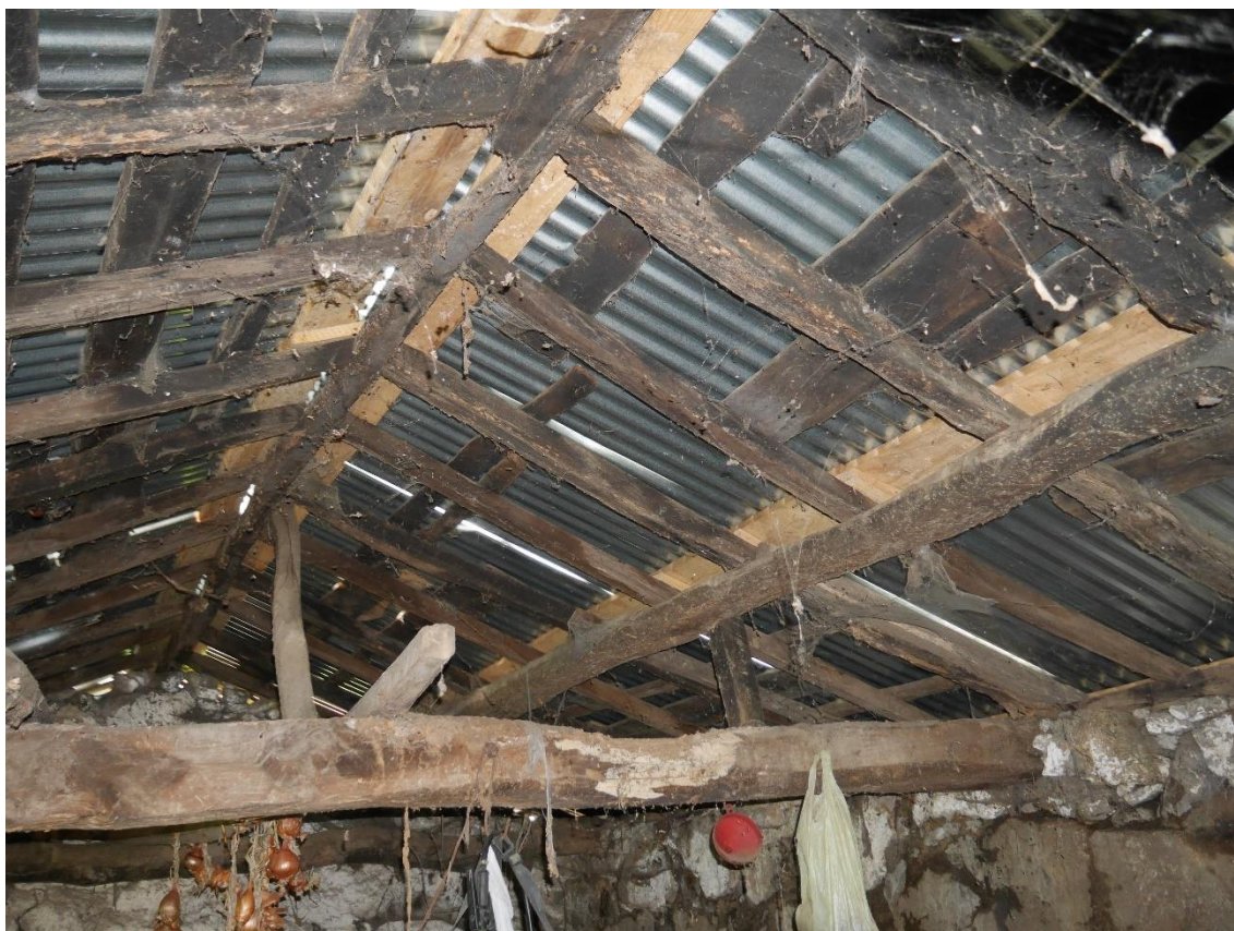
Figura 11 - Estrutura da cobertura em madeira
