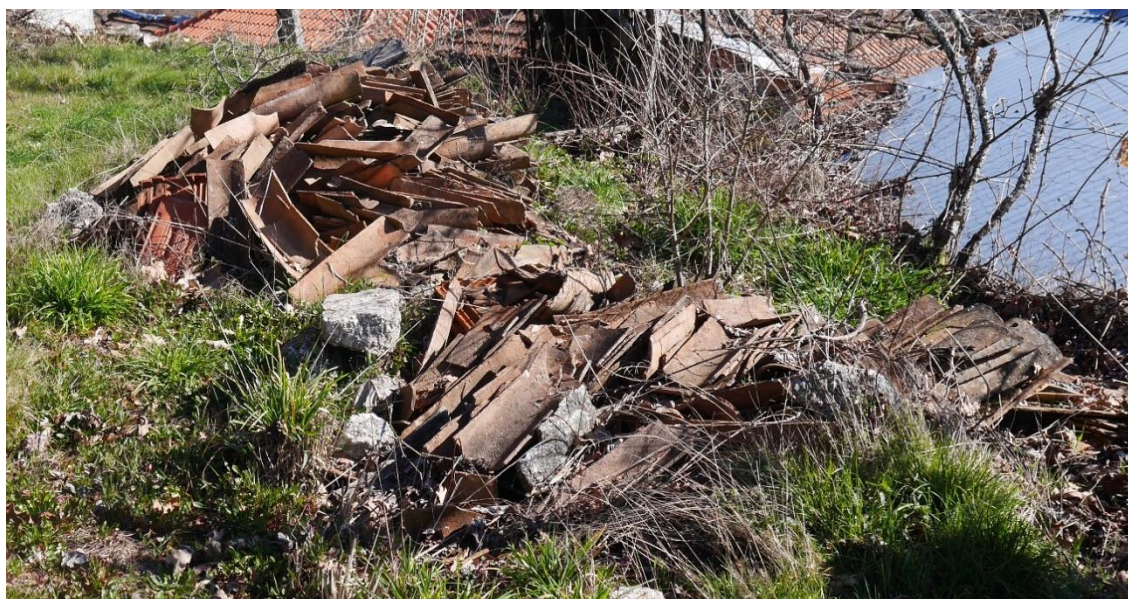
Figura 12 - Telhas originais da casa
