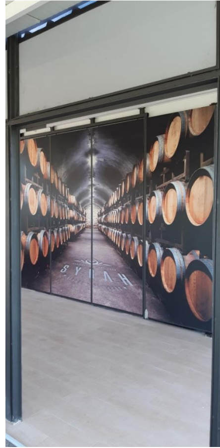
Fotografia 49- Aplicação final de placas de alucobond em portas interiores Fonte- Própria
