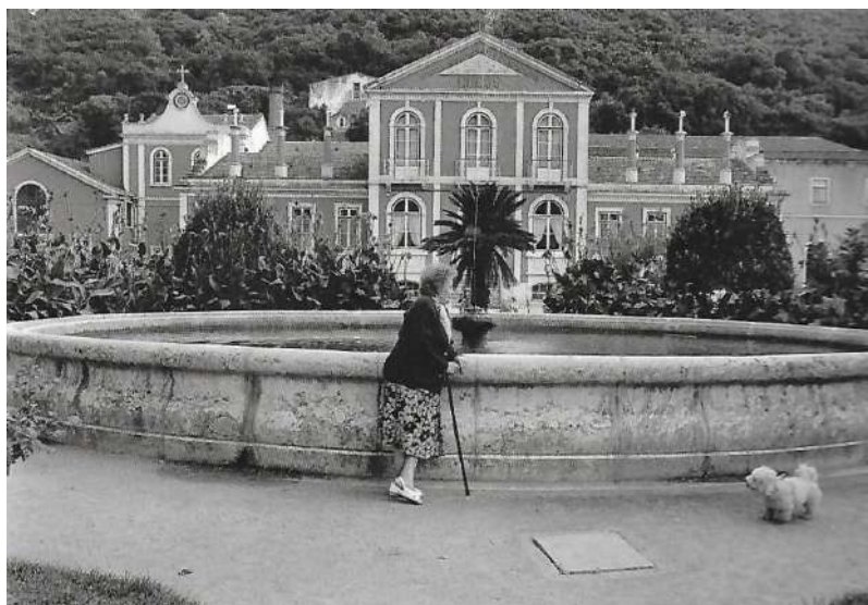
Figura 23. Vista do Estabelecimento Termal do Vale dos Cucos (Azevedo & Vasconcelos , 1995).
