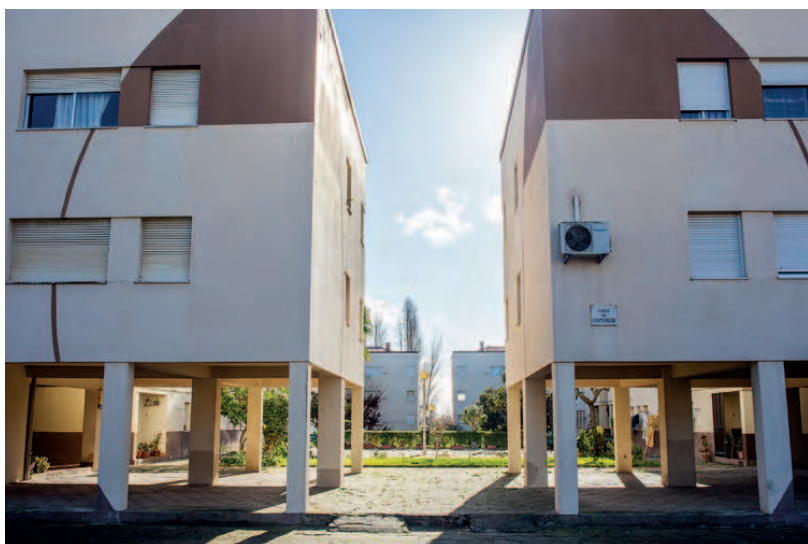
FIG. 11 Fachada principal com o acesso ao interior do quarteirão da CHES, Setúbal, 2017 (Vitor Figueiredo, 1978-1981). João M Almeida
