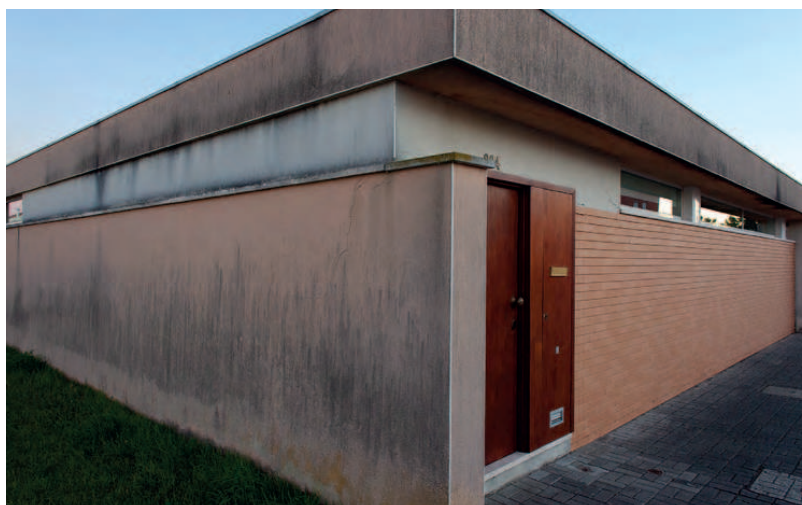
FIG. 17 Habitação unifamiliar isolada da Cooperativa Habitovar, Ovar, 2017 (Pedro Ramalho, Alcino Soutinho, Bernardo Ferrão e Rolando Torgo, 1984). João M Almeida
