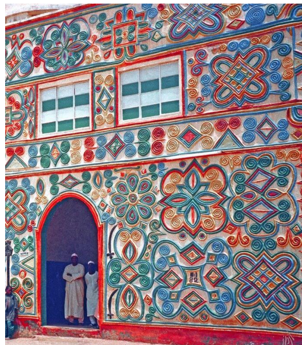
Figura 2.24- Fachada hauçá. Emir de Zazzau, Palácio em Zaria, Nigéria, construído em 1995 (Fonte 24)
