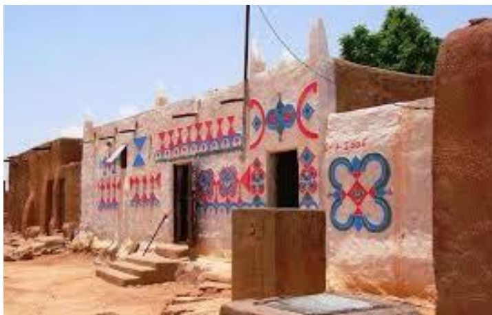
Figura 2.31- Fachada hauçá (Fonte 31)
