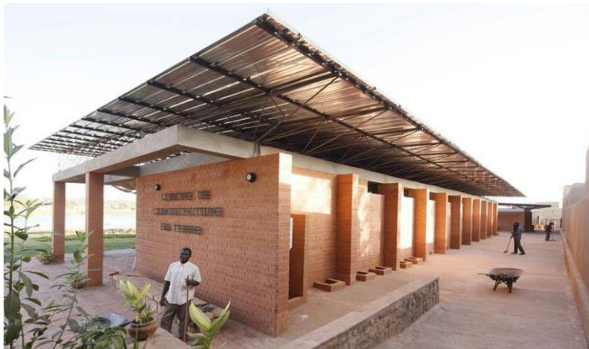
Figura 3.23- Centro de Arquitetura de Terra, fachada sul (Fonte 75)
