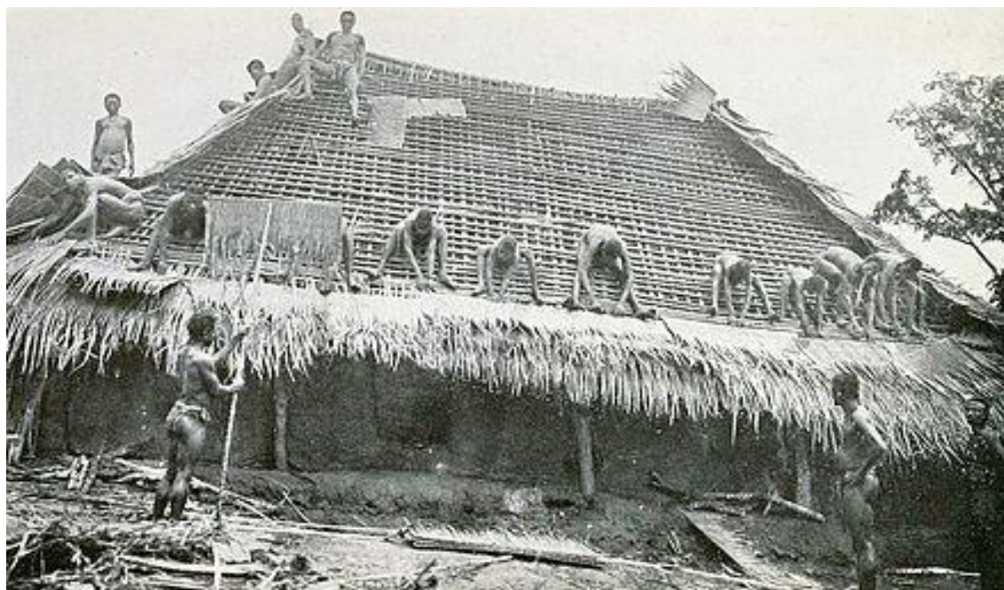
Figura 2.39- Colocação da cobertura com folhas de palmeira, no início do século XX. (Fonte 39)
