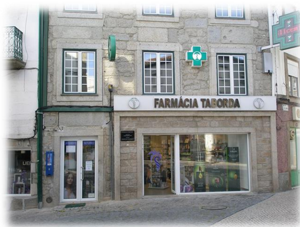
Figura 1 - Fachada principal da Farmácia Taborda.
