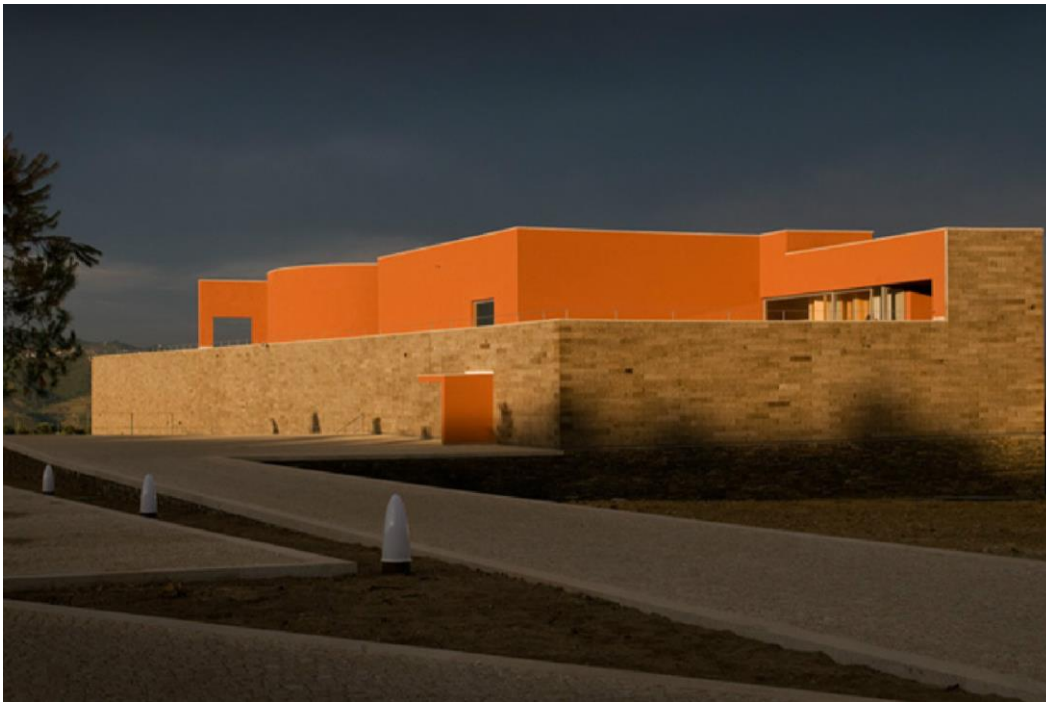
Figura 5.12. Vista geral do Armazém de Estágio e Envelhecimento da Quinta do Portal.
