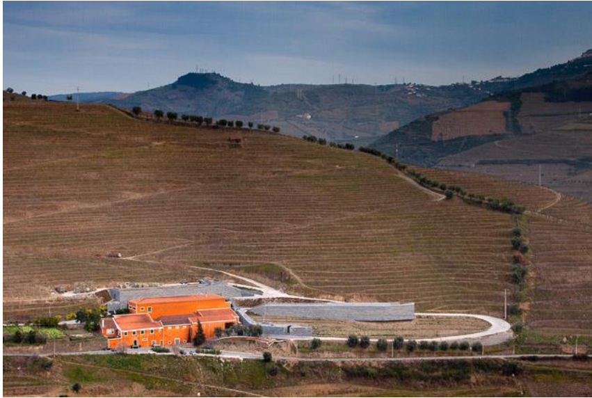
Figura 5.5. Vista geral da zona de produção.
