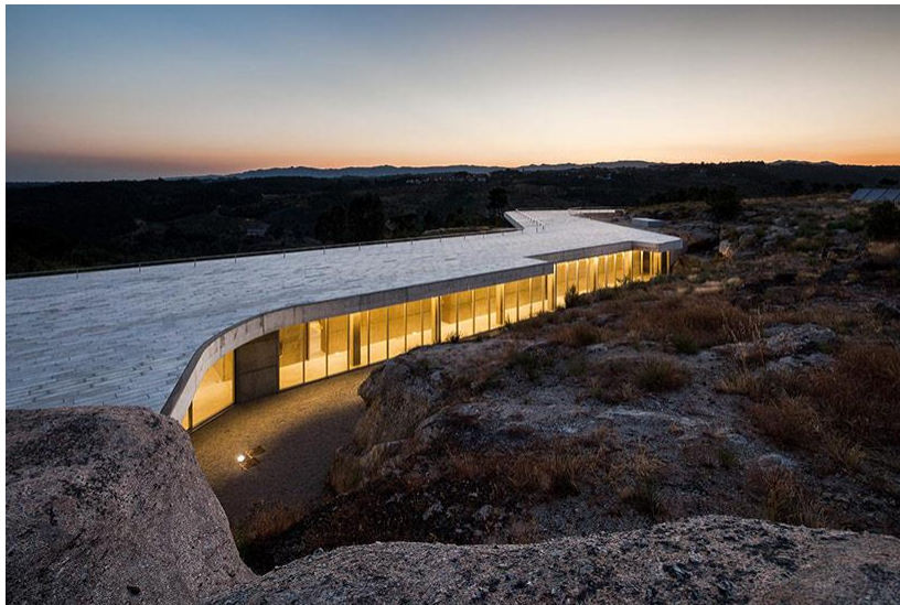
Figura 5.24. Vista geral da Guest House .
