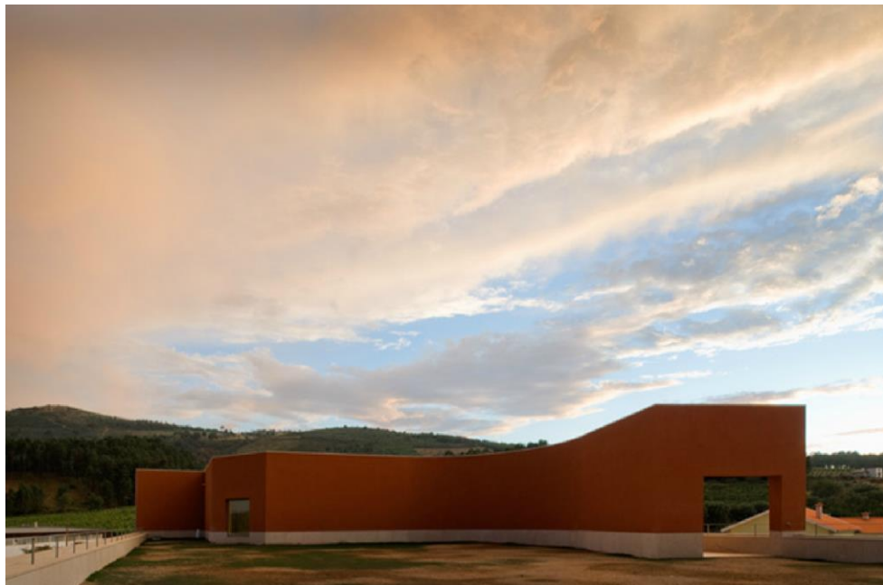
Figura 5.15. Cobertura acessível com o portal e o auditório.
