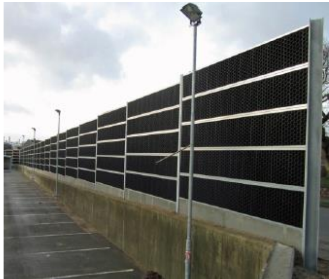
Figura 26b – Exemplos práticos de reciclagem das pás de rotor de aerogeradores eólicos: (f) barreiras de betão pré-fabricado, em New Jersey ; (g) barreiras de isolamento de ruído, (1) elemento de barreira de ruído; (2) material de absorção acústica de fibra de vidro reciclada; (3) têxtil poroso; (4) estrutura protetora aberta (Adaptado de Cefic, EuCia & Wind Europe, 2020)
