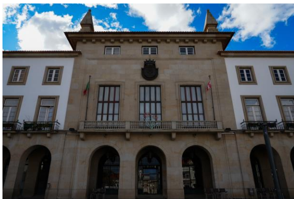
Figura 12. Fachada da autarquia
