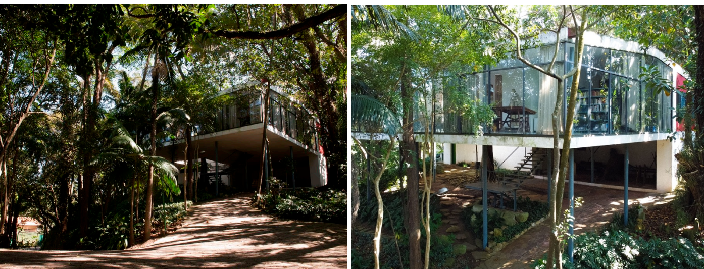
Fig. 17 e 18: Casa de Vidro, Lina Bo Bardi (Instituto Bardi, s.d.)
