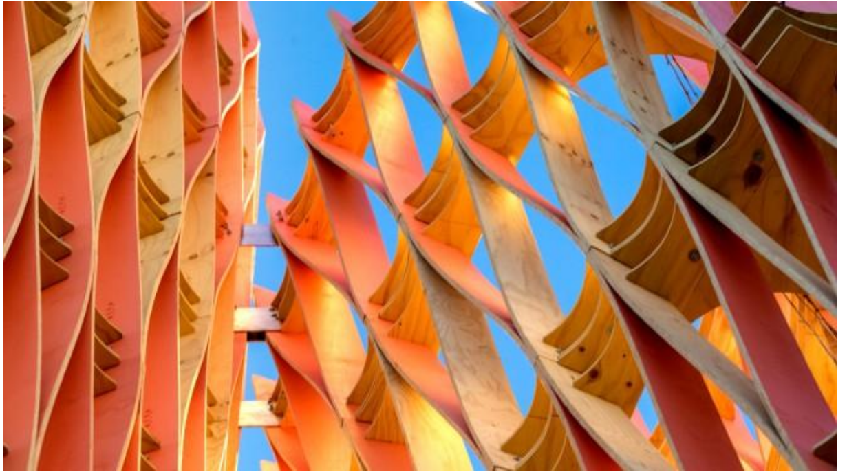
Figura 69 - Placas de madeira digitalmente fabricadas na estrutura da obra. (Fonte: FLORIO, J. em Cornell Chronicle, 2024).
