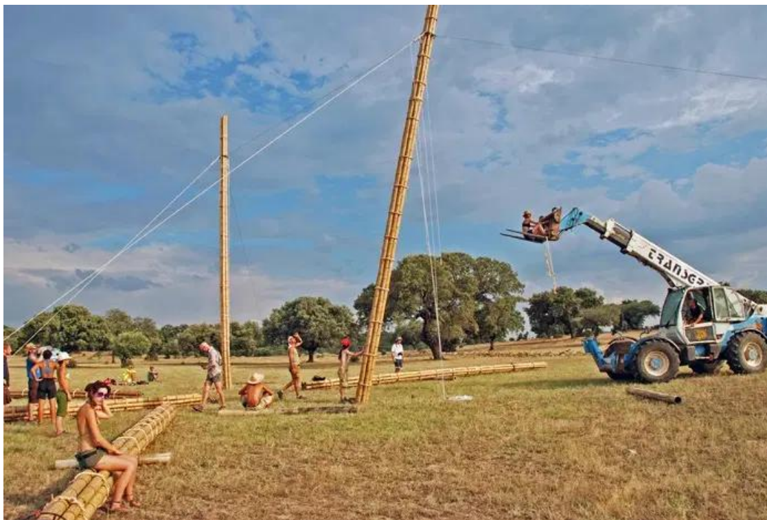
Figura 42 - Fase de construção das estruturas do festival, onde podemos ver os pilares de bambu e cabos utilizados. (Fonte: Boom Festival Gallery).
