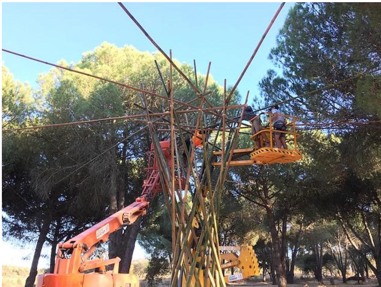
Figura 47 - Processo de construção das torres de bambu da estrutura. (Fonte: Jan Balbaligo – Shade for a Stage, 2019).
