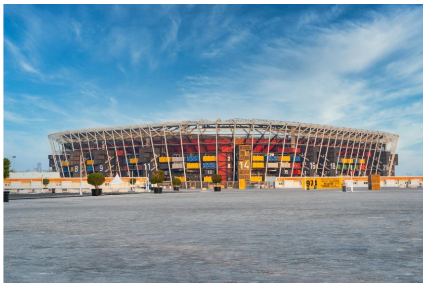
Figura 24 - Stadium 974, Doha, Qatar. (Fonte: RAMLI, F. em ArchDaily Brasil, 2023).
