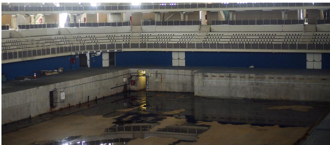
Figura 22 - Estádio Aquático Olímpico, um ano após as Olimpíadas do Rio de Janeiro. (Fonte: OLIVARES, P. em REUTERS, 2017).
