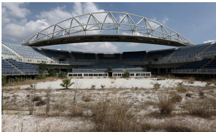
Figura 20 - Campo de vôlei de praia. (Fonte: STAVRAKIS, T. em The Guardian, 2014).
