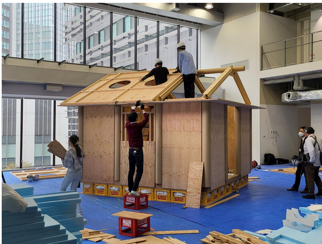
Figura 4 - Construção de protótipo para abrigo temporário em resposta ao terremoto na Turquia/Síria. (Fonte: Shigeru Ban Architects em ArchDaily Brasil, 2023).
