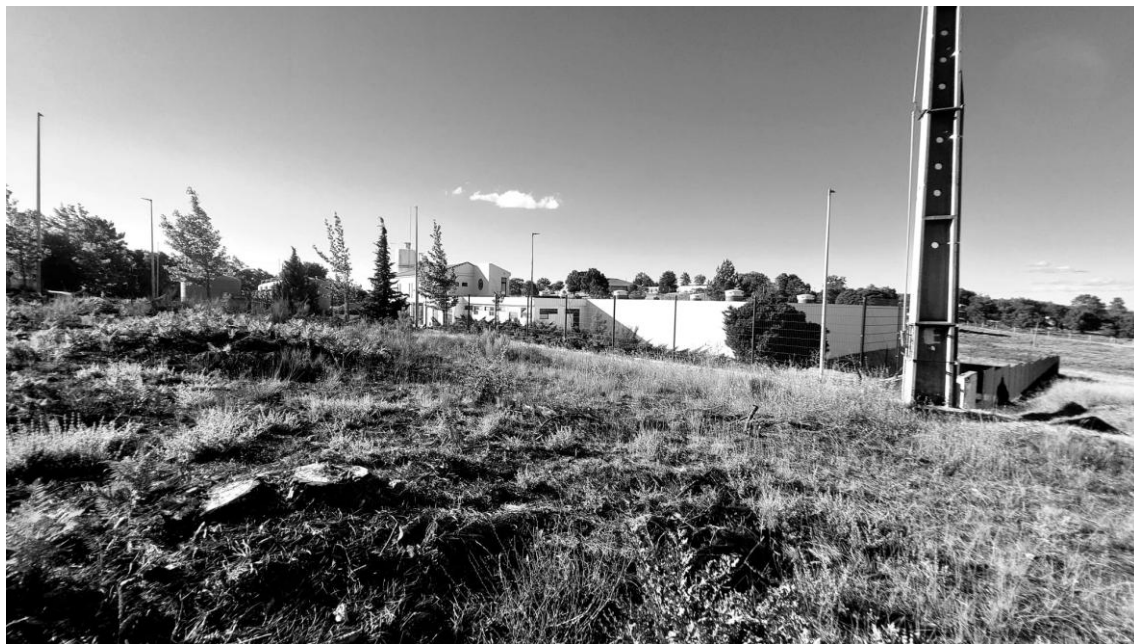
Figura 18: ETA do Sabugal Fonte: O autor Sabugal, Sabugal
