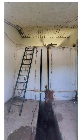
Figura 78: Interior da antecâmara de trabalhos Fonte: O autor Aldeia da Ribeira, Sabugal
