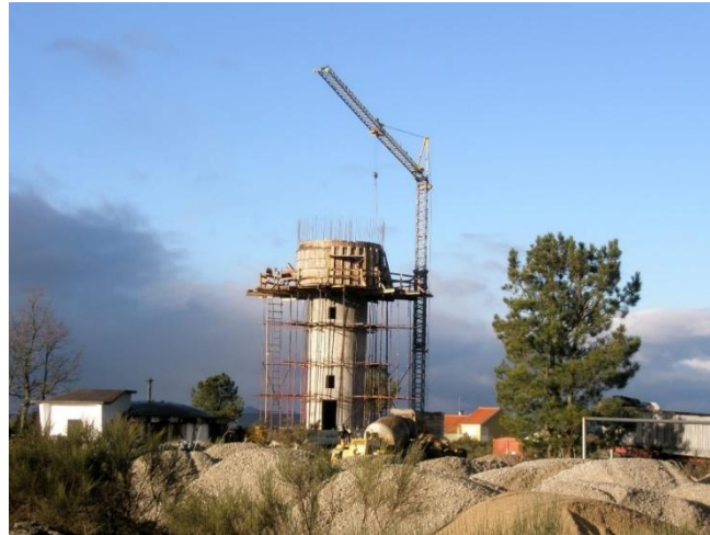
Figura 21: Construção de um novo reservatório (Fonte: José Lages, 2008) Ruvina, Sabugal
