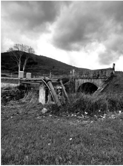
Figura 16: Conduitas expostas na interceção com o leito do rio Fonte: O autor Casteleiro, Sabugal
