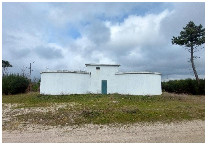
Figura 8: Reservatório de 2 células Fonte: O autor Monte Novo, Sabugal
