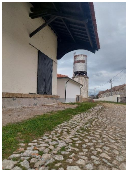
Figura 15: Abandono dos elementos da ferrovia Fonte: O autor Cerdeira do Côa, Sabugal
