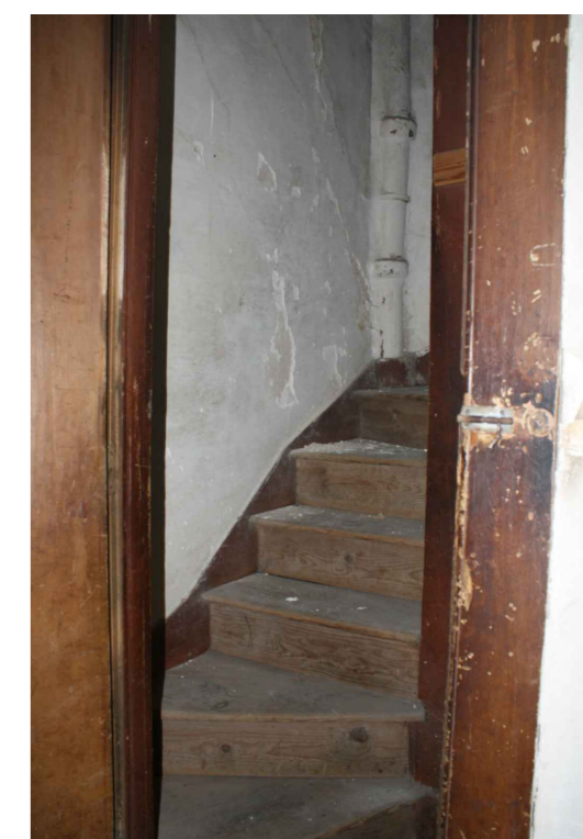
Escadas de Acesso ao Piso 3
