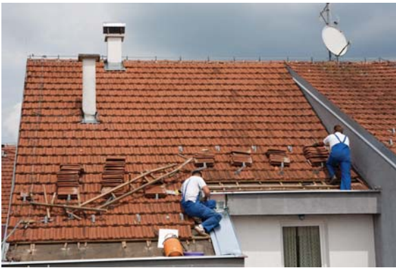
Figura 17. Inclinação do telhado e a sua desconstrução.
