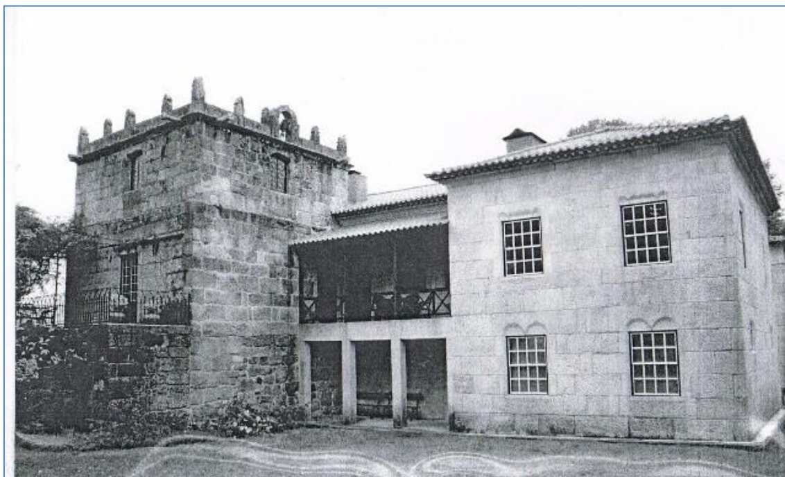
IMAGEM XXXII | Fachada principal da Casa Solar
