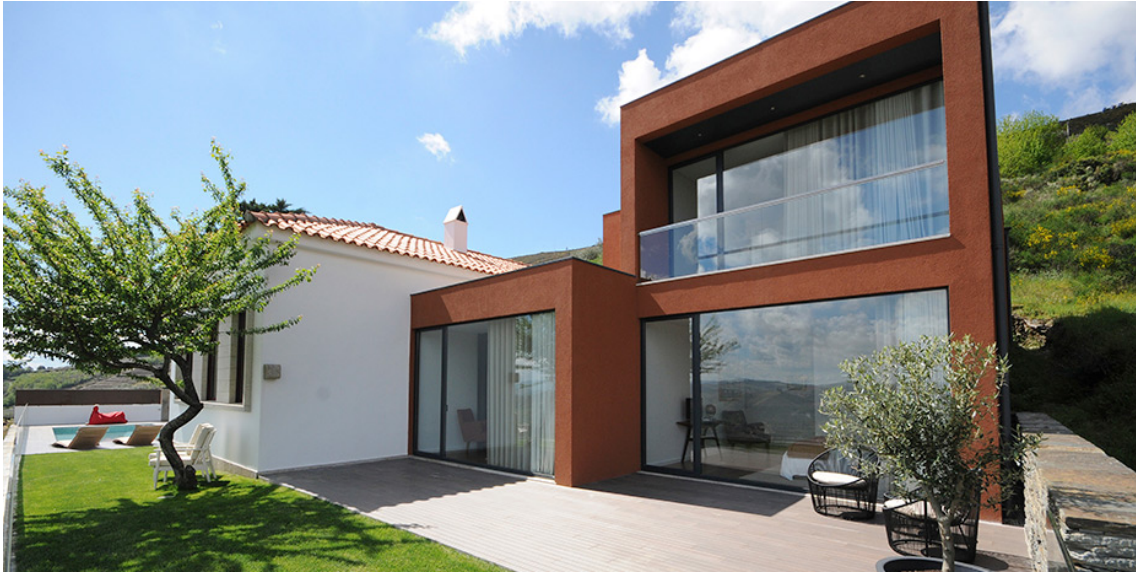
Figura 18 - Alçado tardoz do edifício Lugar das Letras, Gouvães do Douro, Sabrosa, Vila Real
