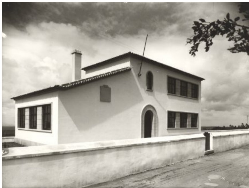
Figura 4 - Escola de Rua, Arrifana, Feira, Aveiro Edifício de 3 salas
