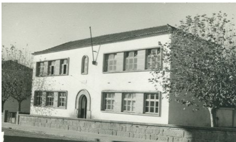
Figura 5 - Escola masculina n.º 3 de Vila do Conde, Porto Edifício escolar de 4 salas simples
