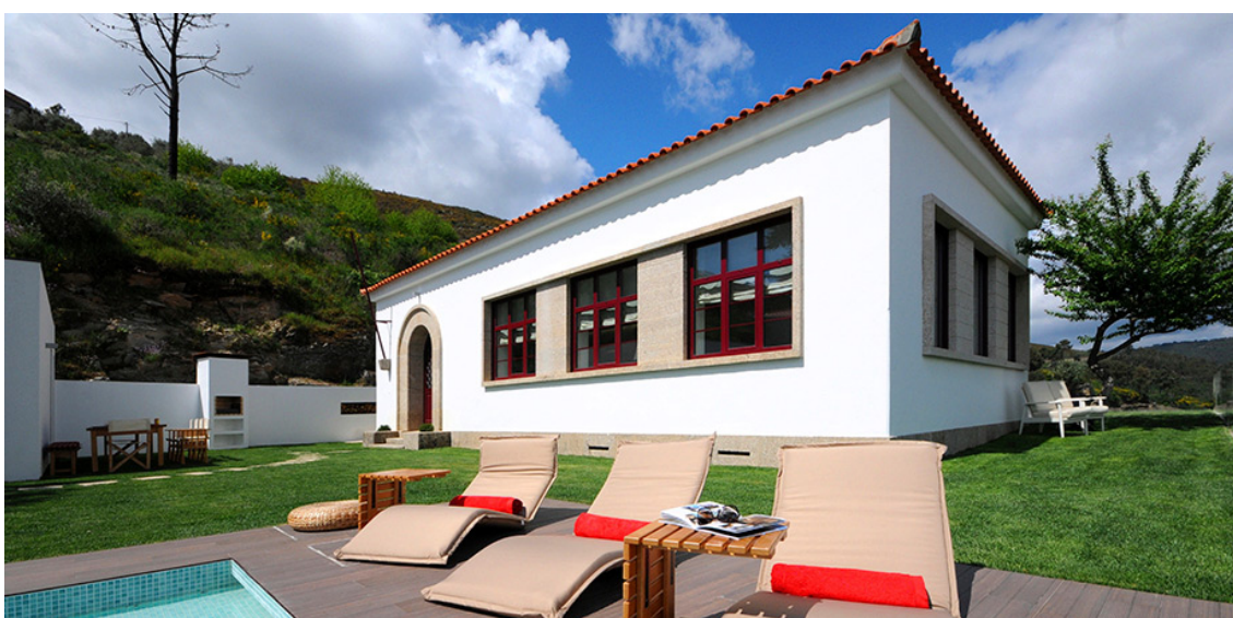
Figura 16 – Alçado principal do edifício Lugar das Letras, Gouvães do Douro, Sabrosa, Vila Real
