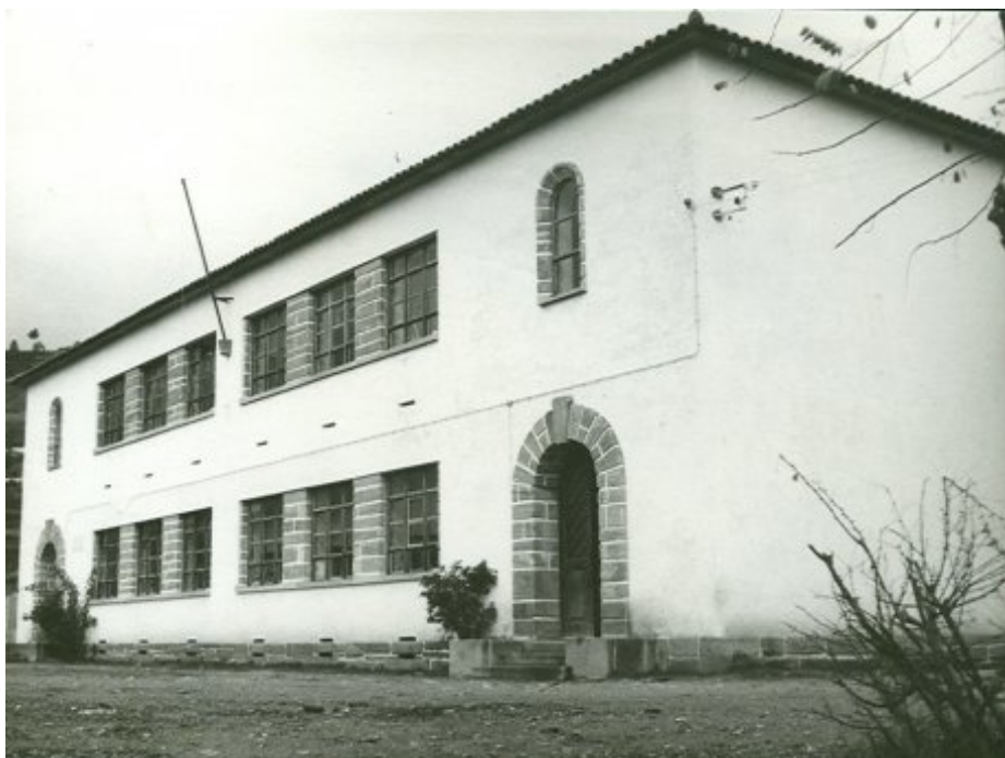
Figura 6 - Escola de Fontes, Santa Marta de Penaguião, Vila Real Edifício escolar de 4 salas
