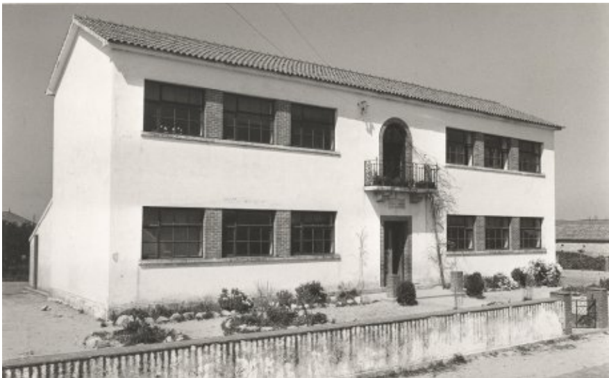
Figura 8 - Escola de S. Silvestre, Bunheiro, Murtosa, Aveiro Edifício de 4 salas, simples
