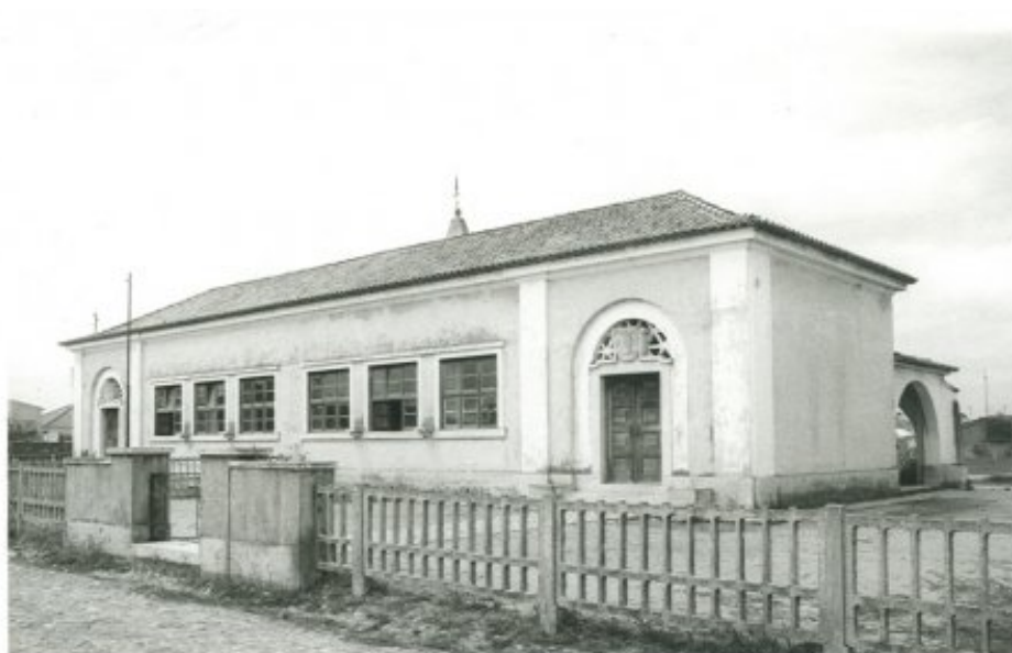
Figura 11 - Escola de Ordem, Concelho da Marinha Grande, Distrito de Leiria Edifício de 2 salas gêmeas
