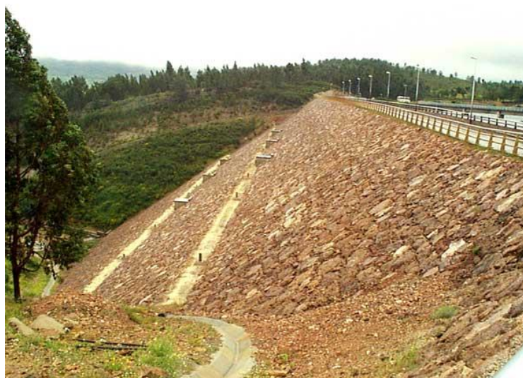
Figura 6 - Barragem de Apartadura (extraído em 14-06-2015 de http://cnpgb.apambiente.pt/gr_barragens/gbportugal/Apartadura.htm )
