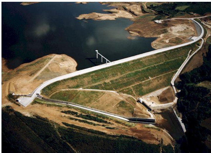
Figura 4 - Barragem de terra do Sabugal (extraído em 14-06-2015 de http://cnpqg.apambiente.pt/gr_barragens/gbportugal/Sabugal.htm )
