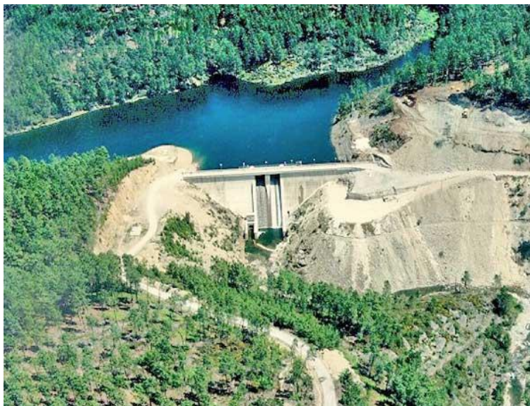
Figura 1 - Barragem de Corgas extraído em 03-07-2015 de ( http://cnpqb.apambiente.pt/gr_barragens/gbportugal/Corgas.htm )
