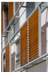
Figura 15 - Portada de protecção solar do Hospital Residencial do Mar, Loures
